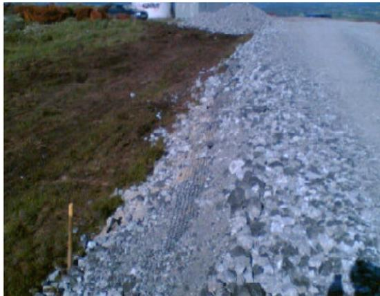
Figura 14: Superficie stradale in misto stabilizzato e drenaggio
