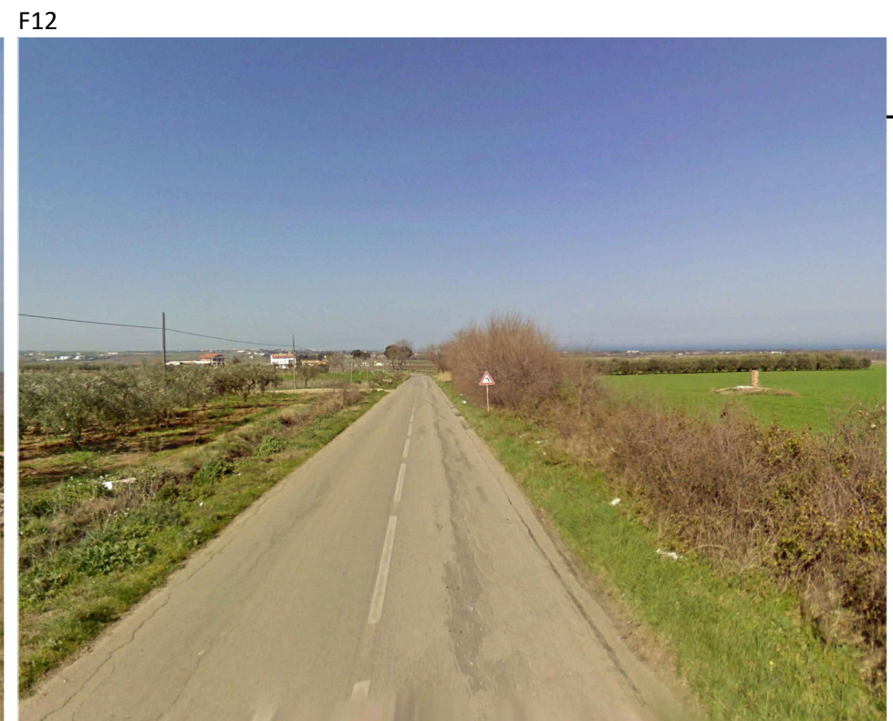
F12 Strada statale n. 16 ter adriatica di avvicinamento al parco eolico larghezza 7,40 metri
