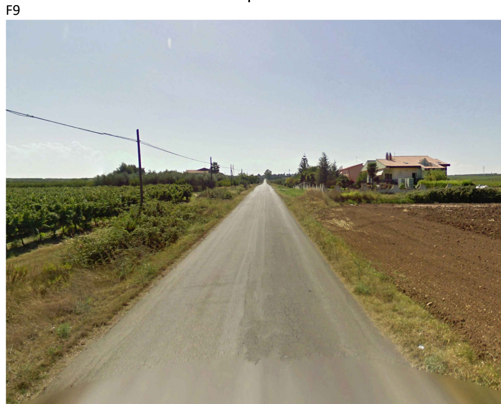
F9 Strada provinciale SP 129 San Martino - Nuova Cliternia di avvicinamento al parco eolico larghezza 5,25 metri
