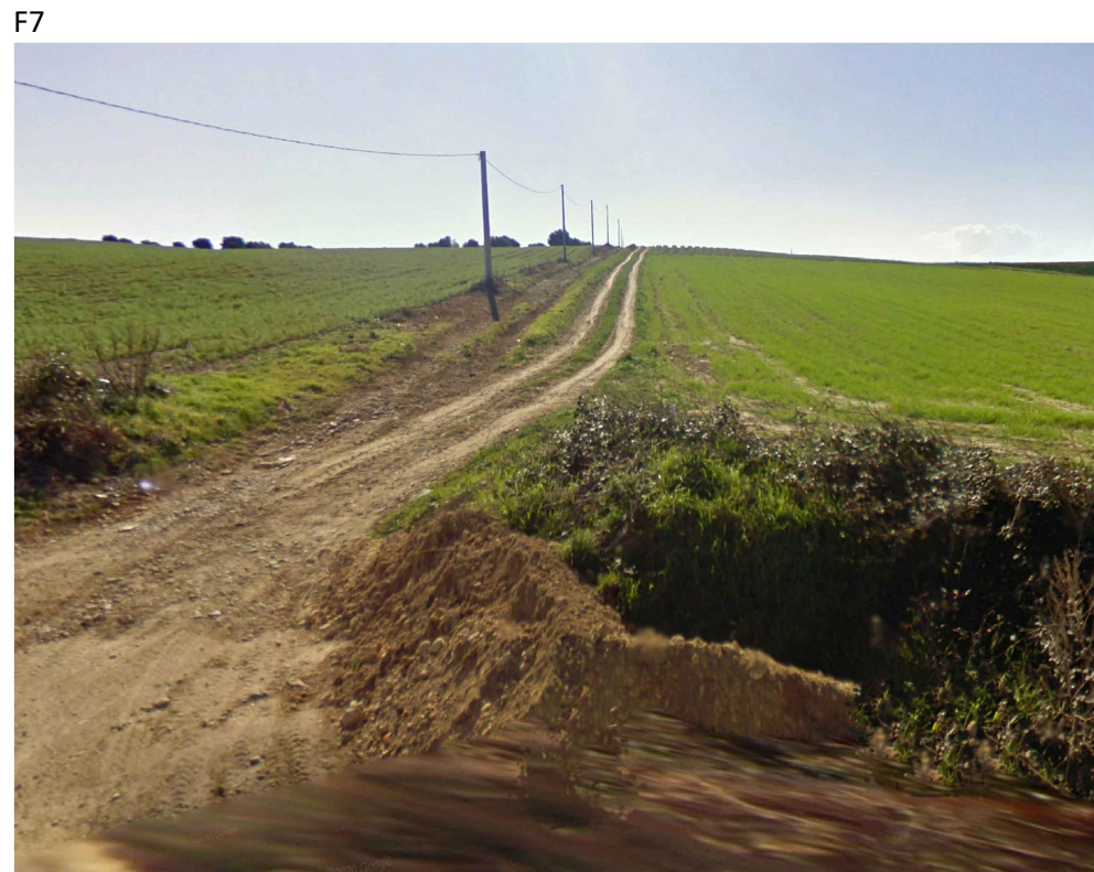
F7 Strada sterrata esistente da destinare a nuova strada per aerogeneratore EDP 01
