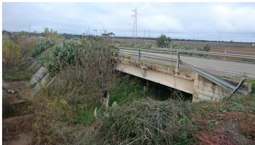
Ponticello attraversamento "C"
