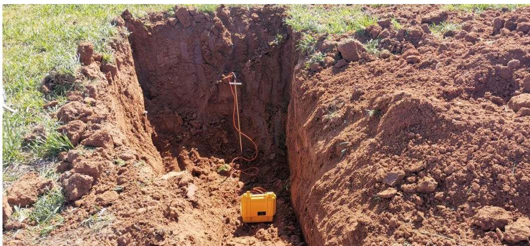
FOTO 9 – MISURA DI RESISTIVITA' TERMICA
