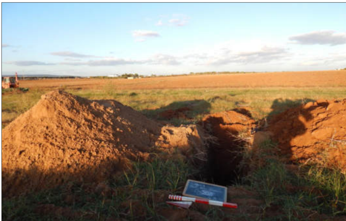
Foto 62. Saggio XV. Particolare del terreno (Nov. 2019)
