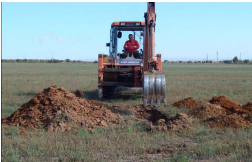
Foto 5. Saggio V. Fasi di scavo: indagini geologiche (Nov. 2019)
