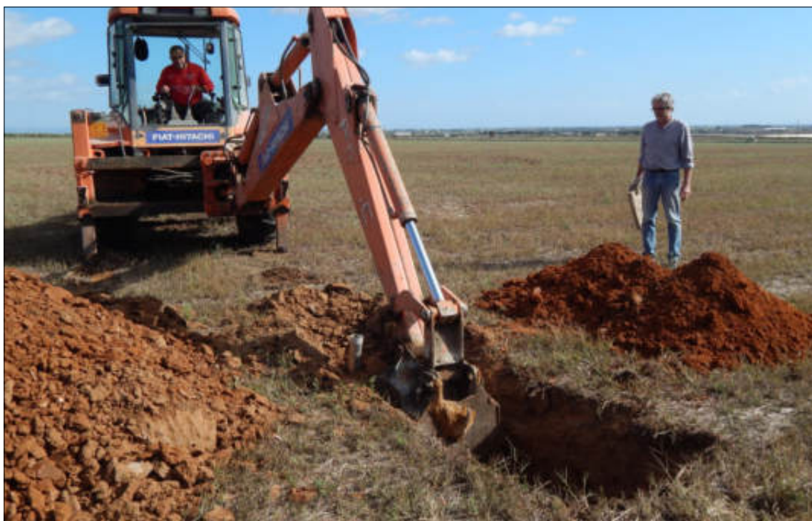
Foto 18. Fase di scavo (Nov. 2019)
