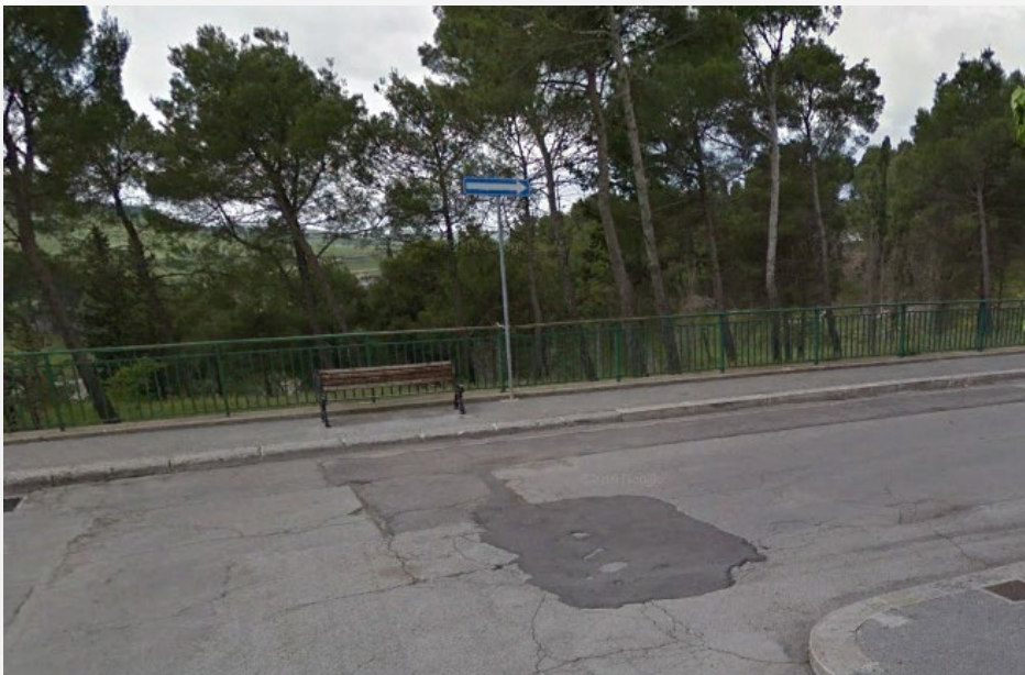
Figura 18 strada esterna all'abitato di Gravina in Puglia, via Dante Alighieri punto 3
