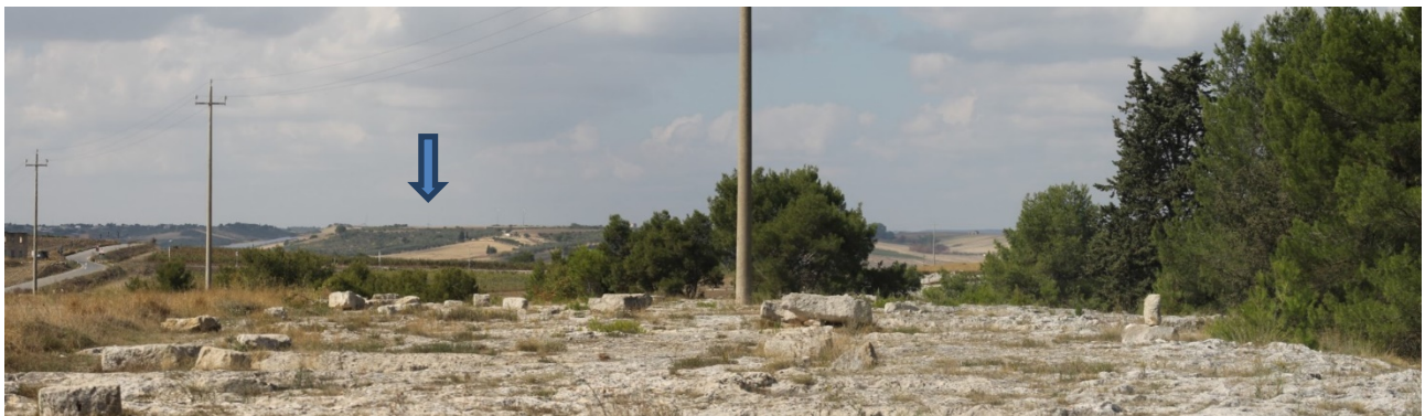
Figura 23 punto di scatto n.2 – stato di fatto con indicazione dell'area impianto
