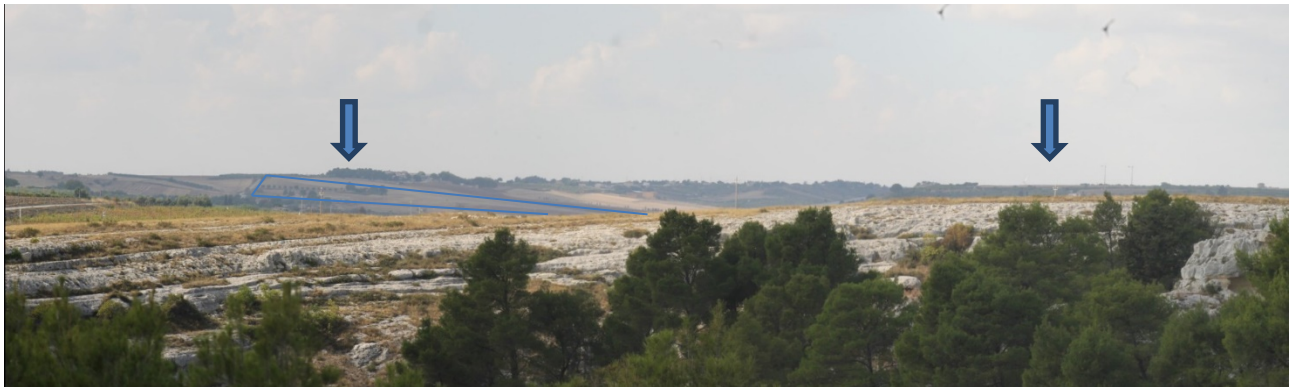
Figura 25 punto di scatto n.4 – stato di fatto con indicazione dell'area impianto
