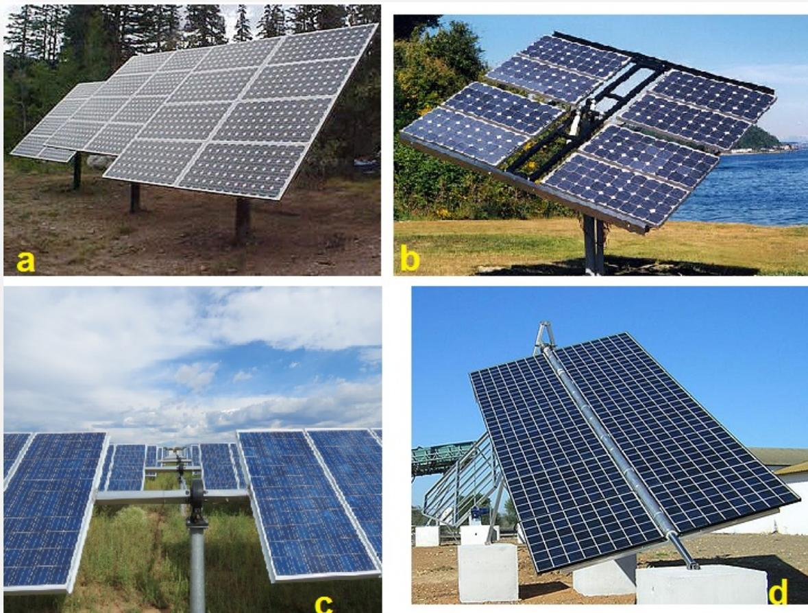
Figura 52 - Sistemi ad inseguimento: a) inseguitore di tilt, b) inseguitore di azimut, c) inseguitore di rollio, d) inseguitore ad asse polare.
