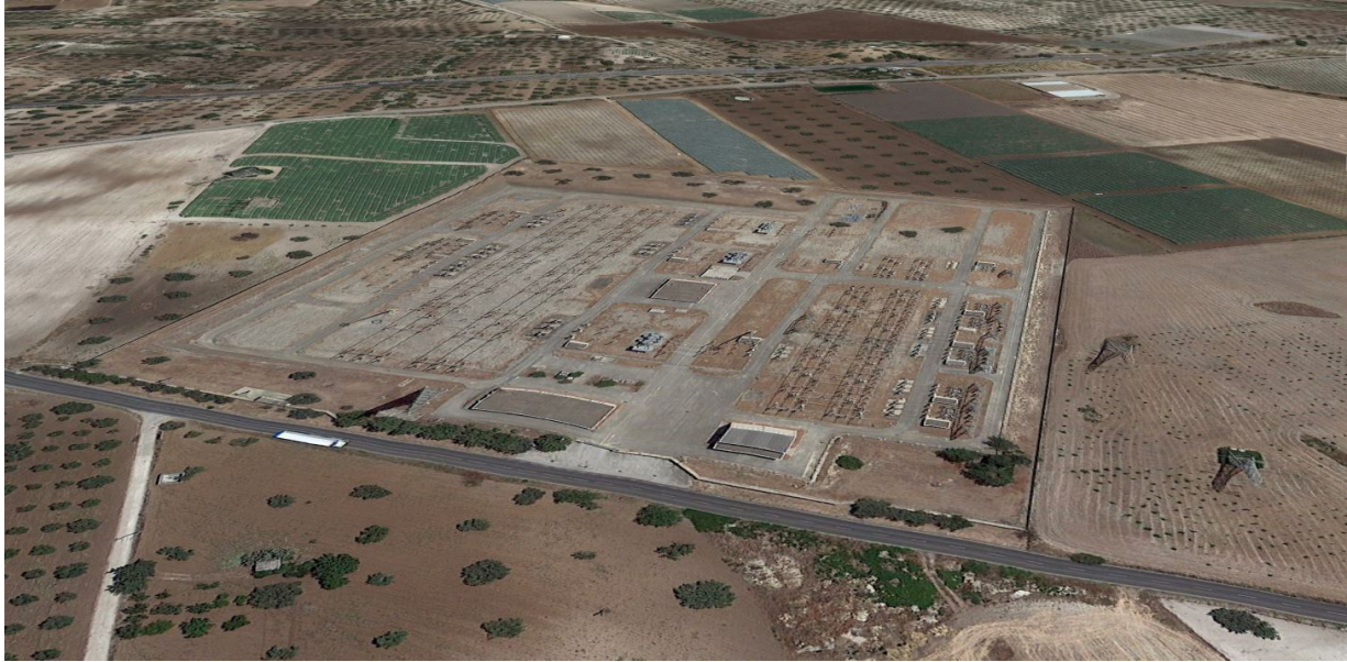
Figura 30 – Immagine della SE 380 kV Chiaramonte Gulfi di Terna.
