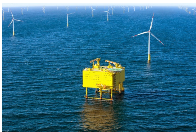
Fig. 8, 9 - Sottostazione elettrica offshore HVDC.
