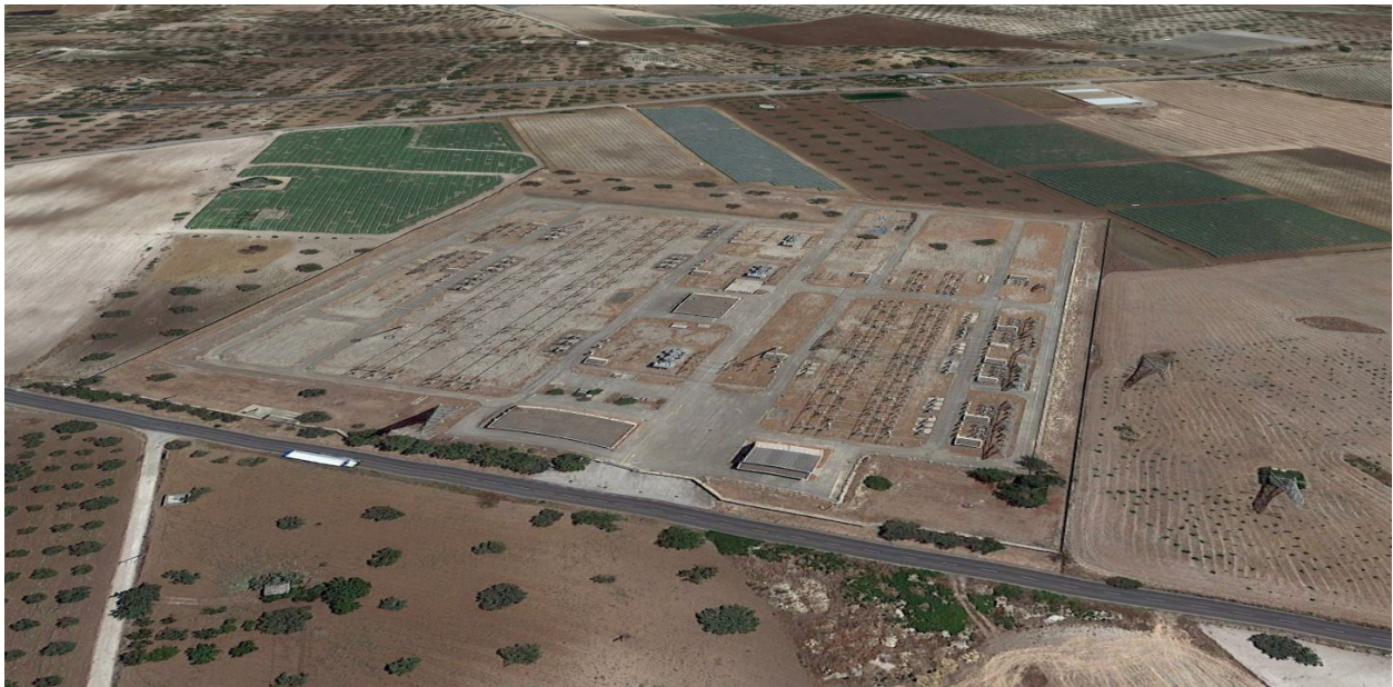
Figura 4 – Immagine della SSE 380 kV Chiaramonte Gulfi di Terna
