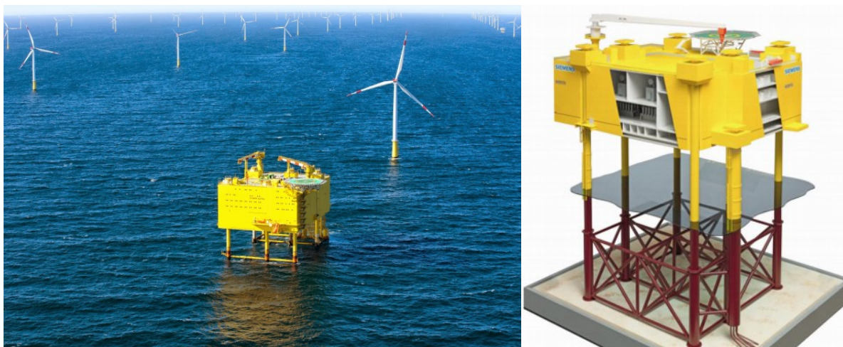
Figura 8 – Stazione HVAC di trasformazione e conversione 66/500 kV
