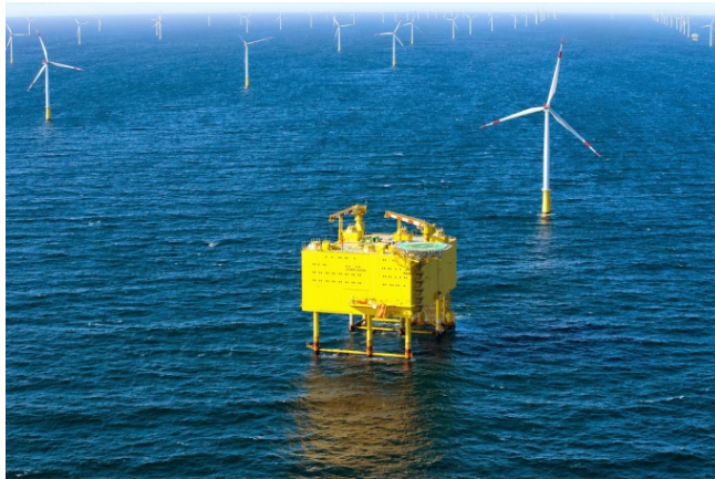
Fig. 7-8 - Sottostazione elettrica offshore HVDC.
