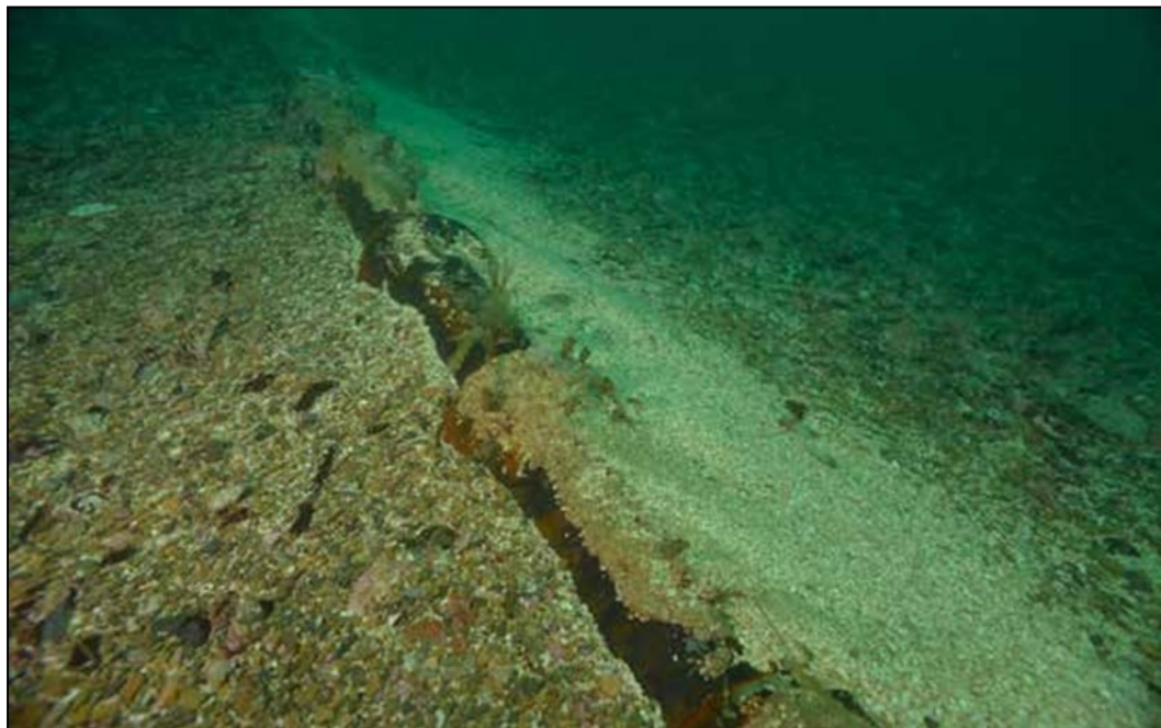
Figura 7: esempio di accumulo di detrito sul cavidotto (da Normandeau et al., 2011).
