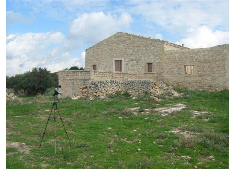
Posizionamento dello strumento fonometrico
