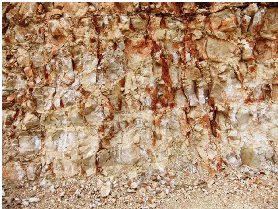
Foto 19 - Particolare fronte Cava Nacalino
