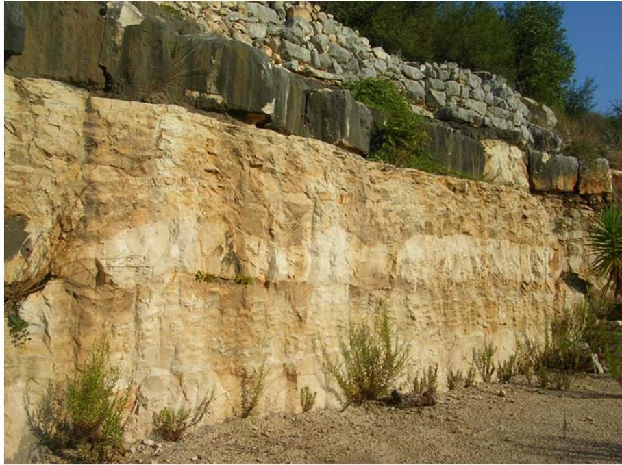
*Figura 4 – Scavo esposto in calcari della Formazione Ragusa*
