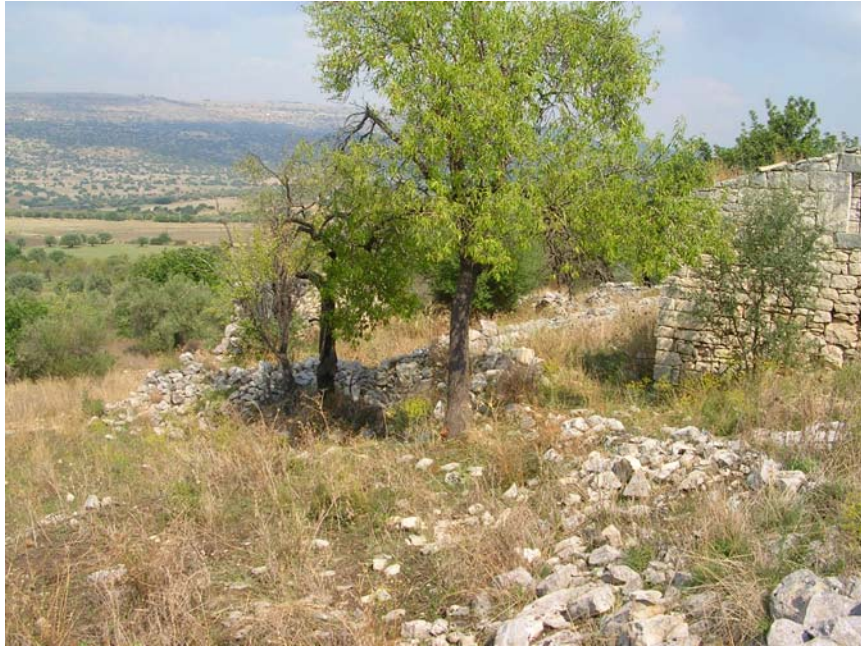
Figura 89 – Area dell'imbocco Nord della Galleria Truncafila
