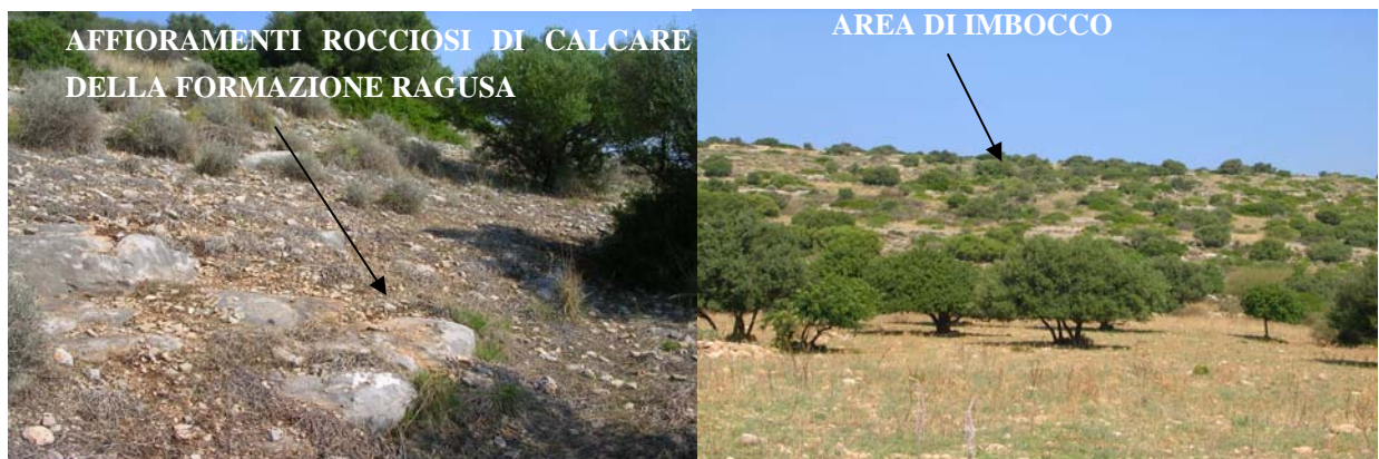
Figura 139 – Area dell'imbocco Ovest della Galleria Occhipinti
