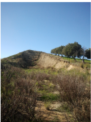
FOTO 3 - VERSANTE NE, ASPETTO DEGLI SCAVI LUNGO IL CONFINE
