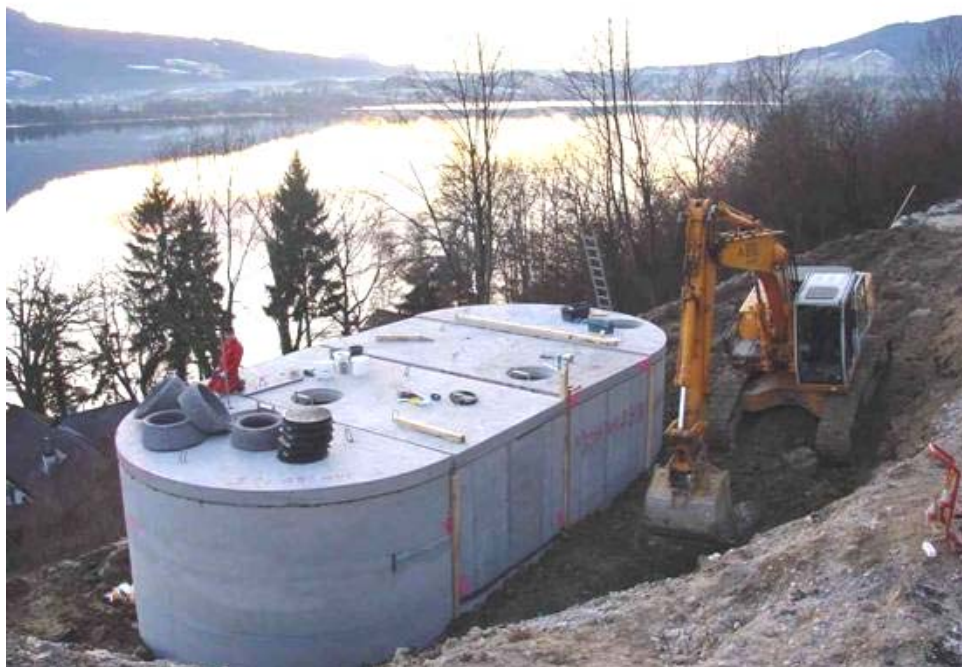
Figura 10.1 – Esempio di montaggio di vasca disoleatrice con sedimentatore primario e filtri a pacchi lamellari
