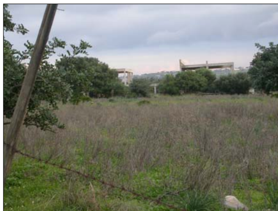
Fig. 6. C.da San Francischiello: la UR I/4 e il campo fotovoltaico visto da Ovest.
