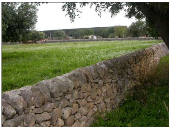
Fig. 5. C.da San Francischiello: la UR I/6 e il campo fotovoltaico visto da Nord.
