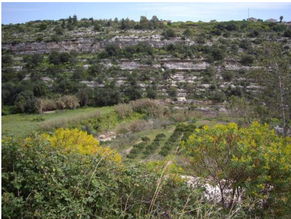
Fig. 4.1 – Area del Cantiere C.1 – vista 1
