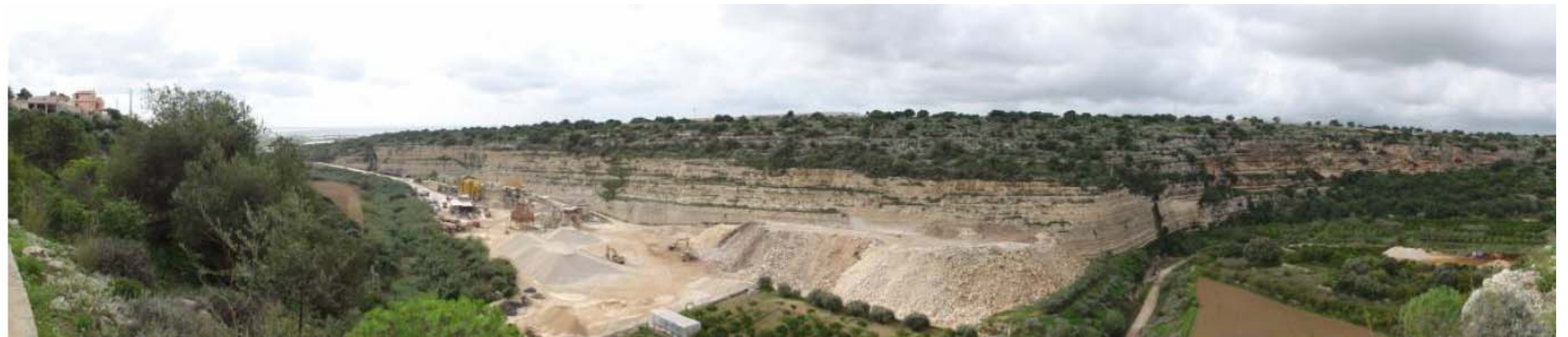
Fig. 7-12 - Vista dell'alveo del Torrente Modica – Scicli (cono 2)
