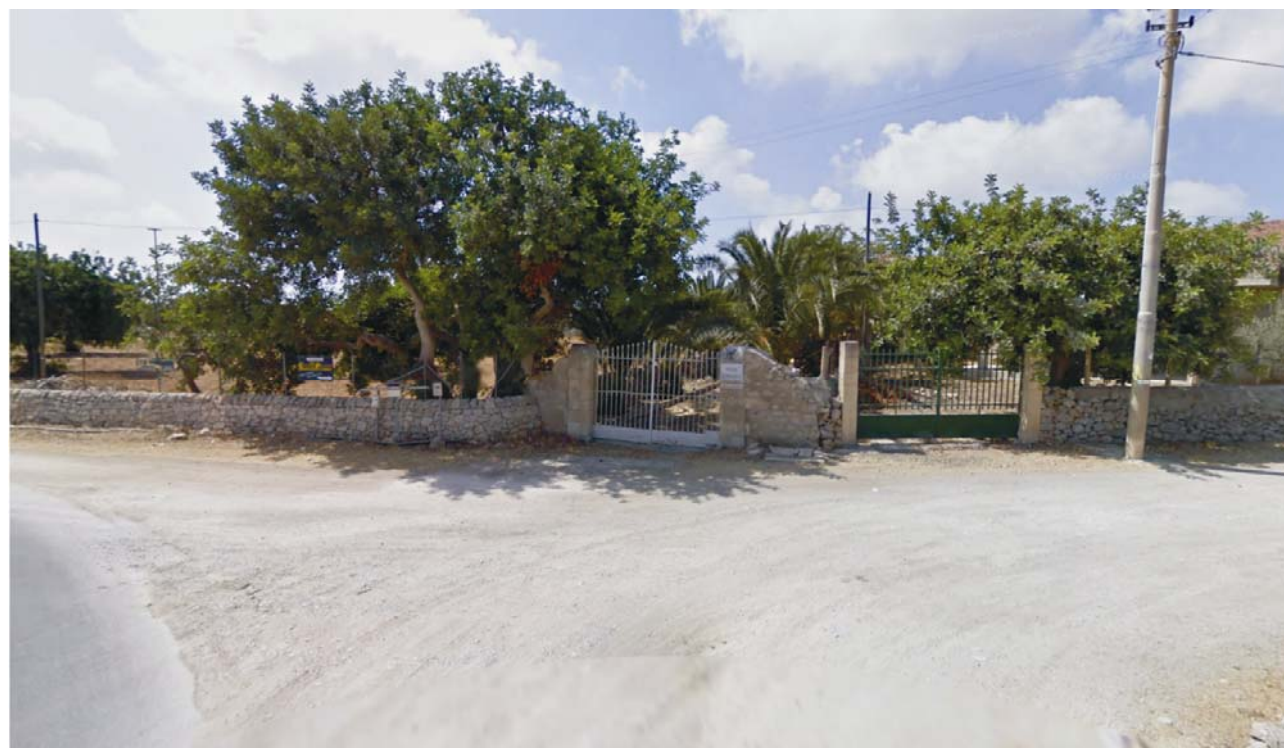
Fig. 5-34 - Contrada Gerrantini – Villa Santa Rosalia – Particolare dell'accesso
