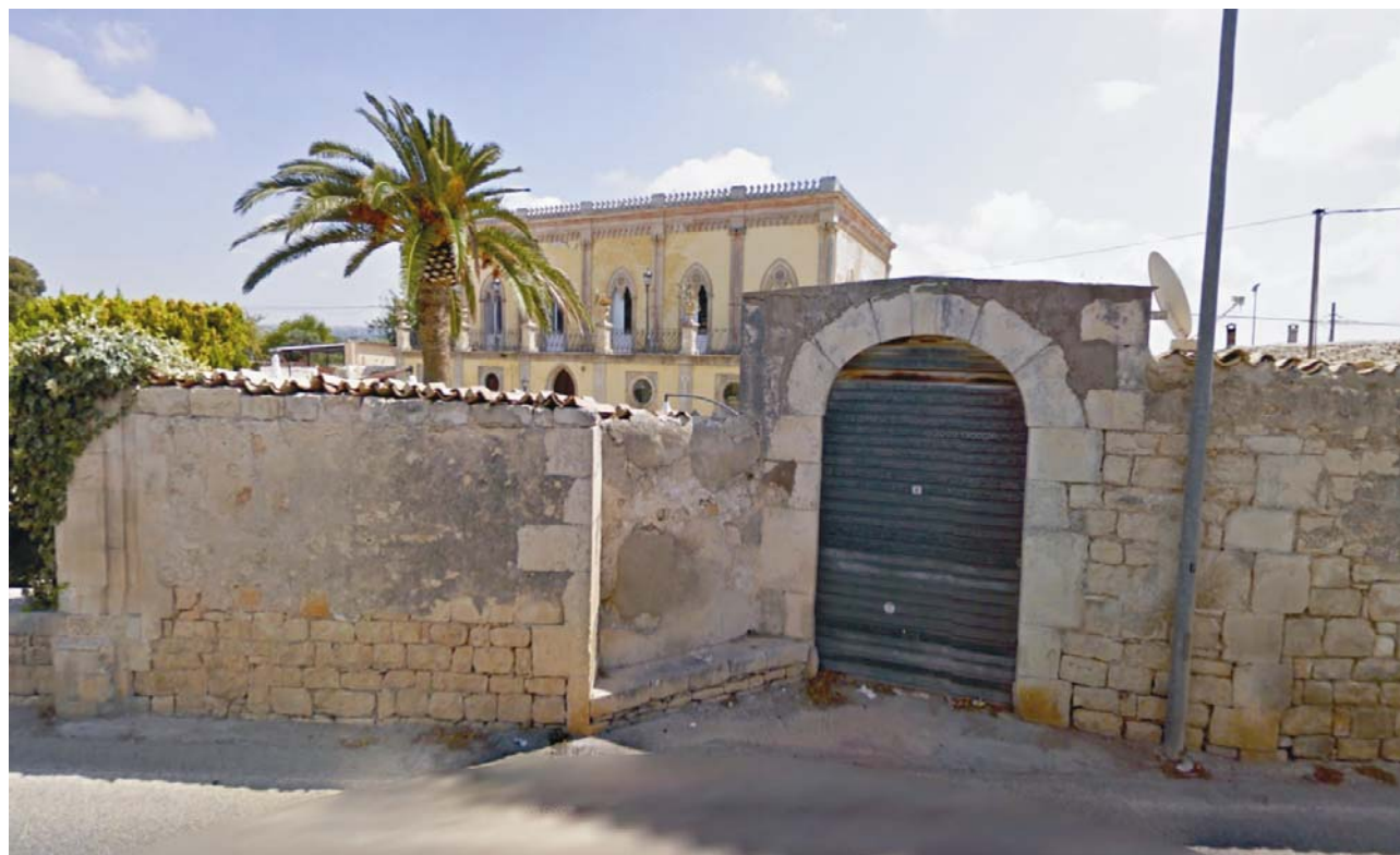
Fig. 5-28 - Villa Sant'Agata – Altra vista dalla strada SP40
