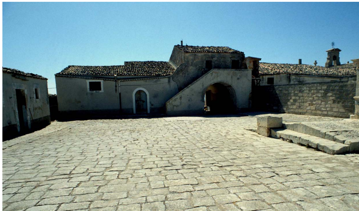
Fig. 5-15 - Tipica masseria ragusana – Particolare della casa del padrone sull'aia [Fonte: G. Leone]
