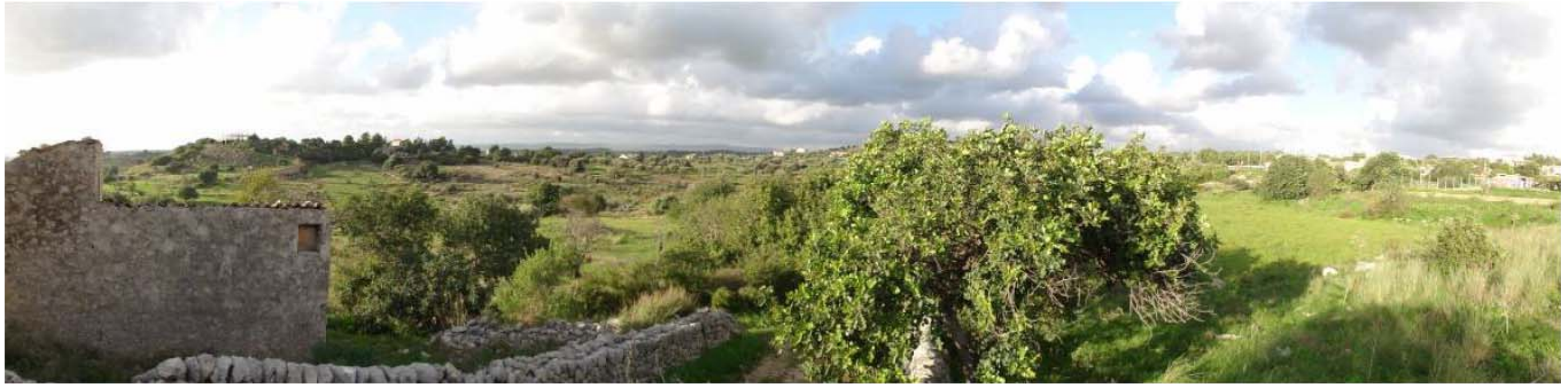
Fig. 7-8 - Lotto 9– Tratto in corrispondenza della vasca di accumulo (cono 1)
