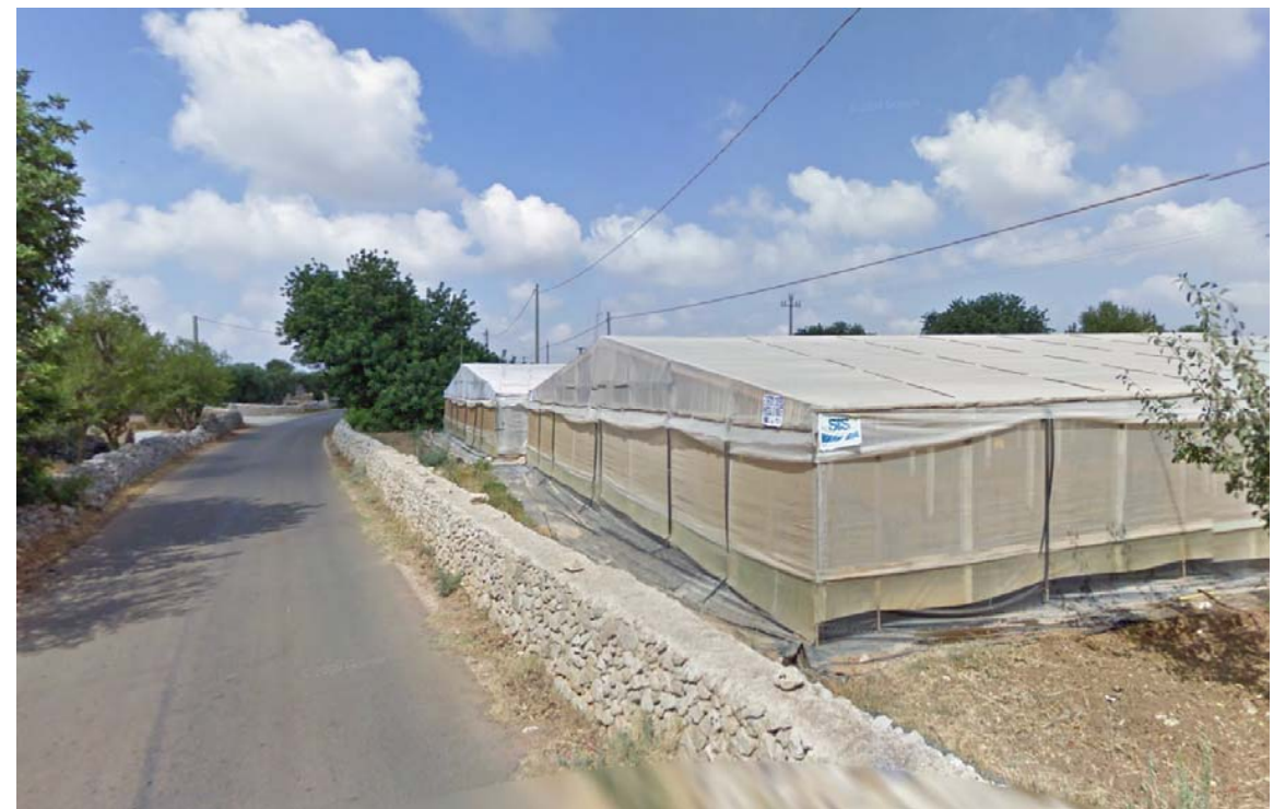
Fig. 7-6 - Strada Provinciale n. 41 – Vista verso la rotatoria (cono 4).
