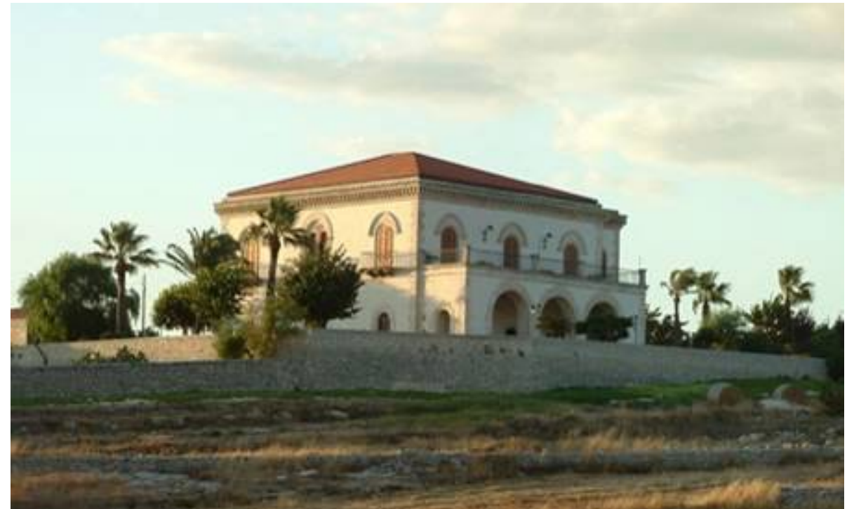
Fig. 5-16 - Villa Ottaviano – Particolare del corpo padronale.
