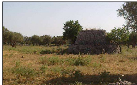
Fig. 12. C.da Catteto/Barracche (Scicli): i c.d. muragghi a torre che reimpiegano il pietrame frutto della bonifica dei campi.
