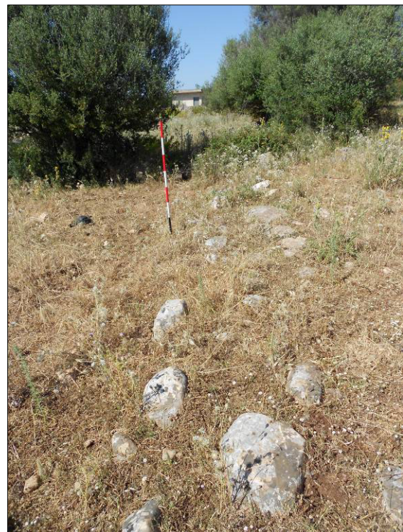
Fig. 20. C.da Catteto/Barracche (Scicli): i resti di un muro a doppio paramento sul pianoro della UR II/4, da Ovest.
