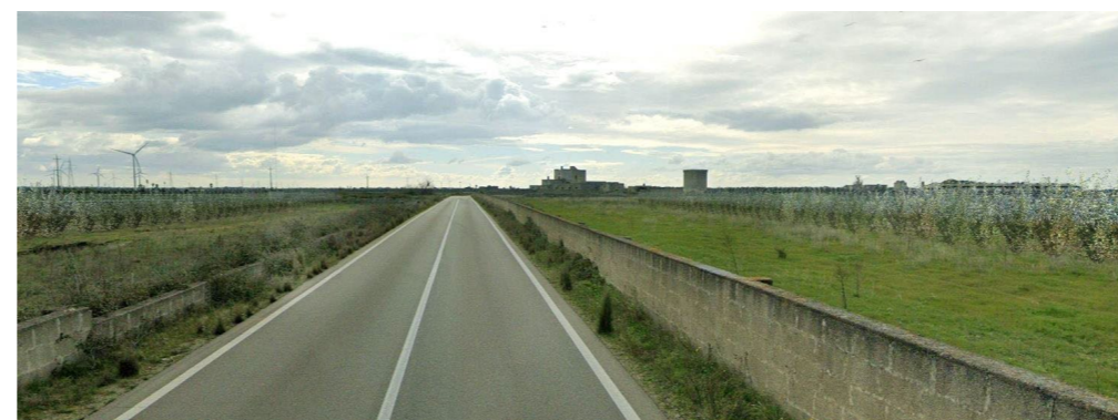
Strada Provinciale 236 – Panoramica Impianto 90 post operam
