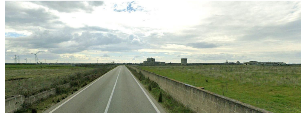
Strada Provinciale 236 – Panoramica Impianto 90 ante operam
