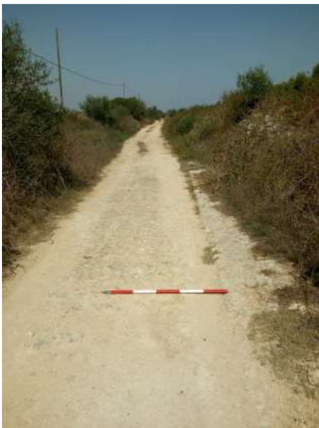
Carrareccia ad est dell'area dell'impianto.
