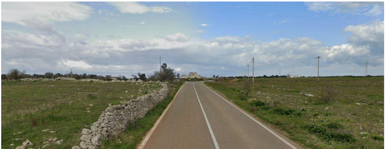
Figura 6-1: Strada Provinciale SP236
