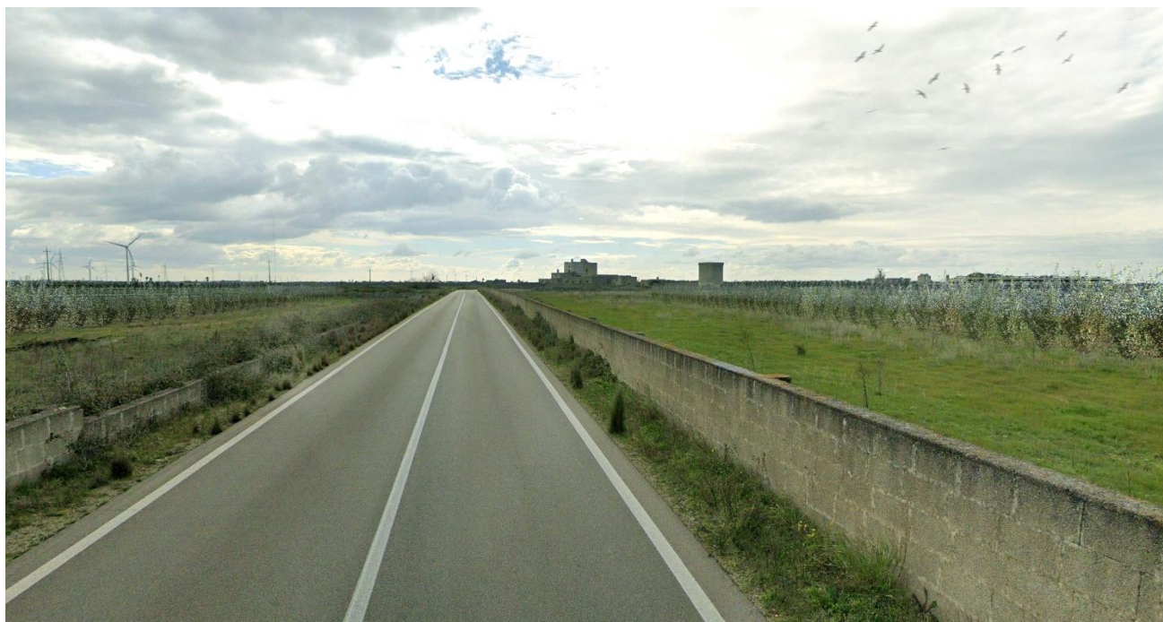
Panoramica dal Punto 09 – post operam
