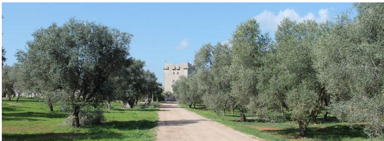
Figura 6-11: Vista da P4 – Ante operam
