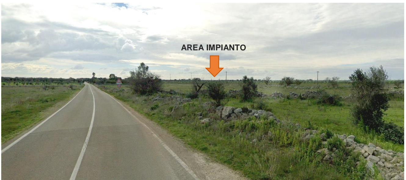
Panoramica dal Punto 06 – post operam
