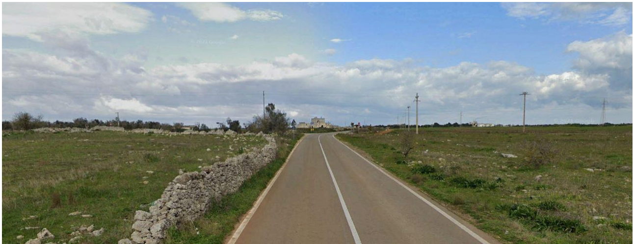
Figura 2-4: Strada Provinciale SP236
