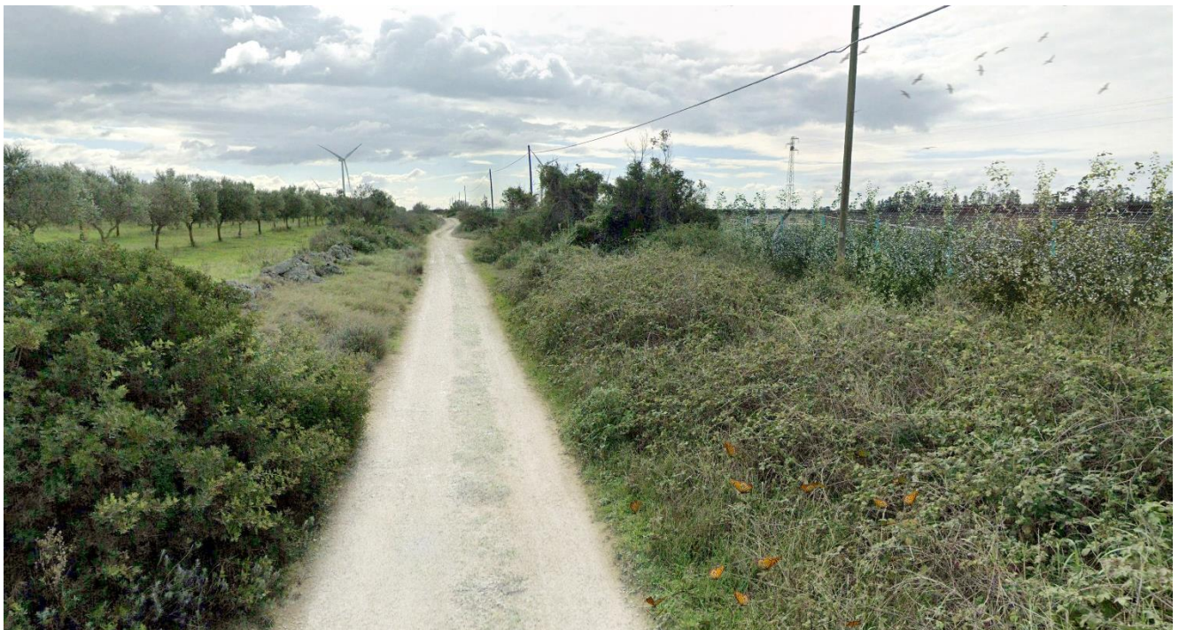
Panoramica dal Punto 08 – post operam
