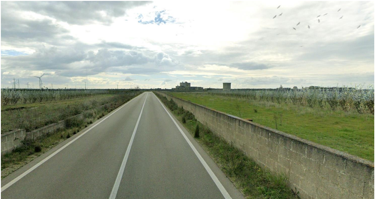
Panoramica dal Punto 09 – post operam
