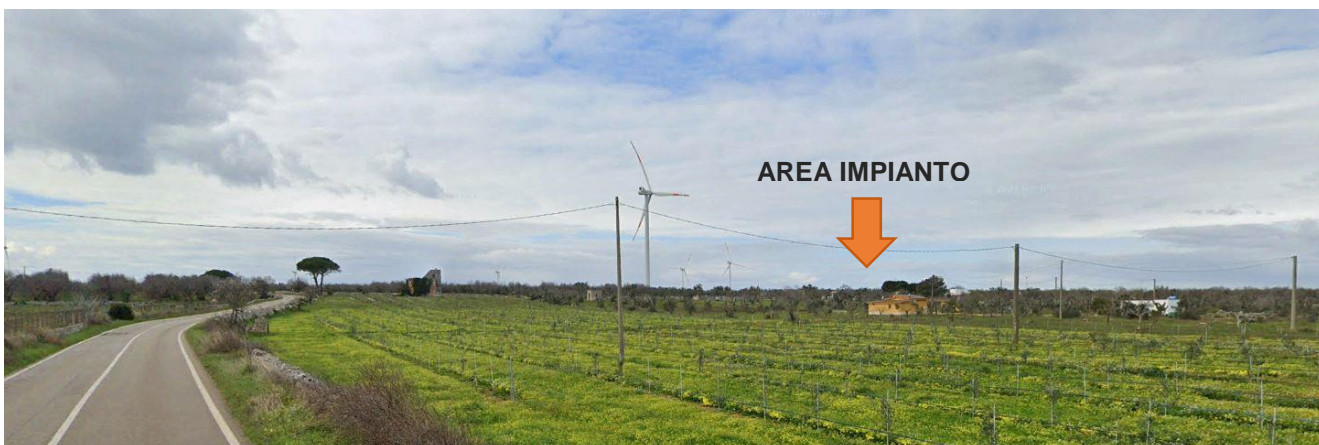
Panoramica dal Punto 03 – post operam
