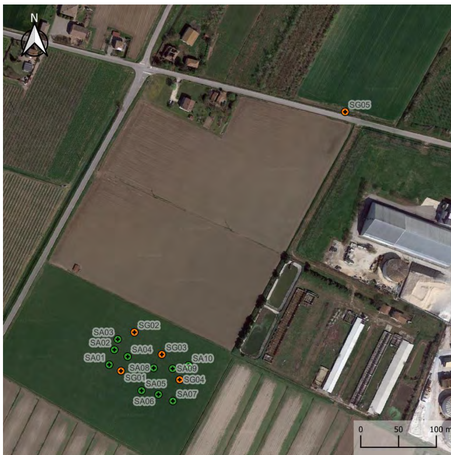
Figura 4.2 ubicazione indagini di caratterizzazione in corrispondenza dell'area della futura sottostazione elettrica (sondaggi ambientali punti verdi e sondaggi ambientali/geognostici punti arancioni)
