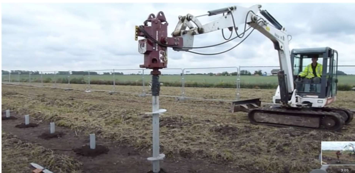
Figura 12-2 Macchina Operatrice per fissaggio supporti strutture
