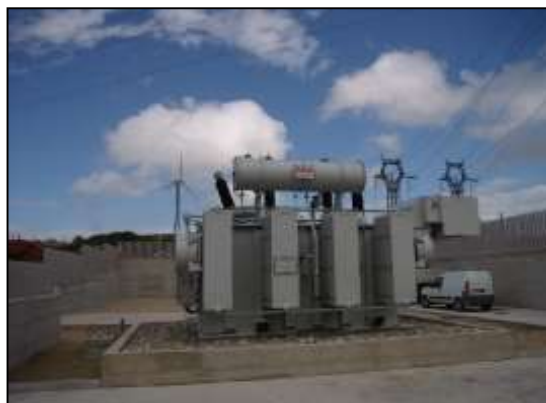
Figura 4-8 Trasformatore MT/AT
