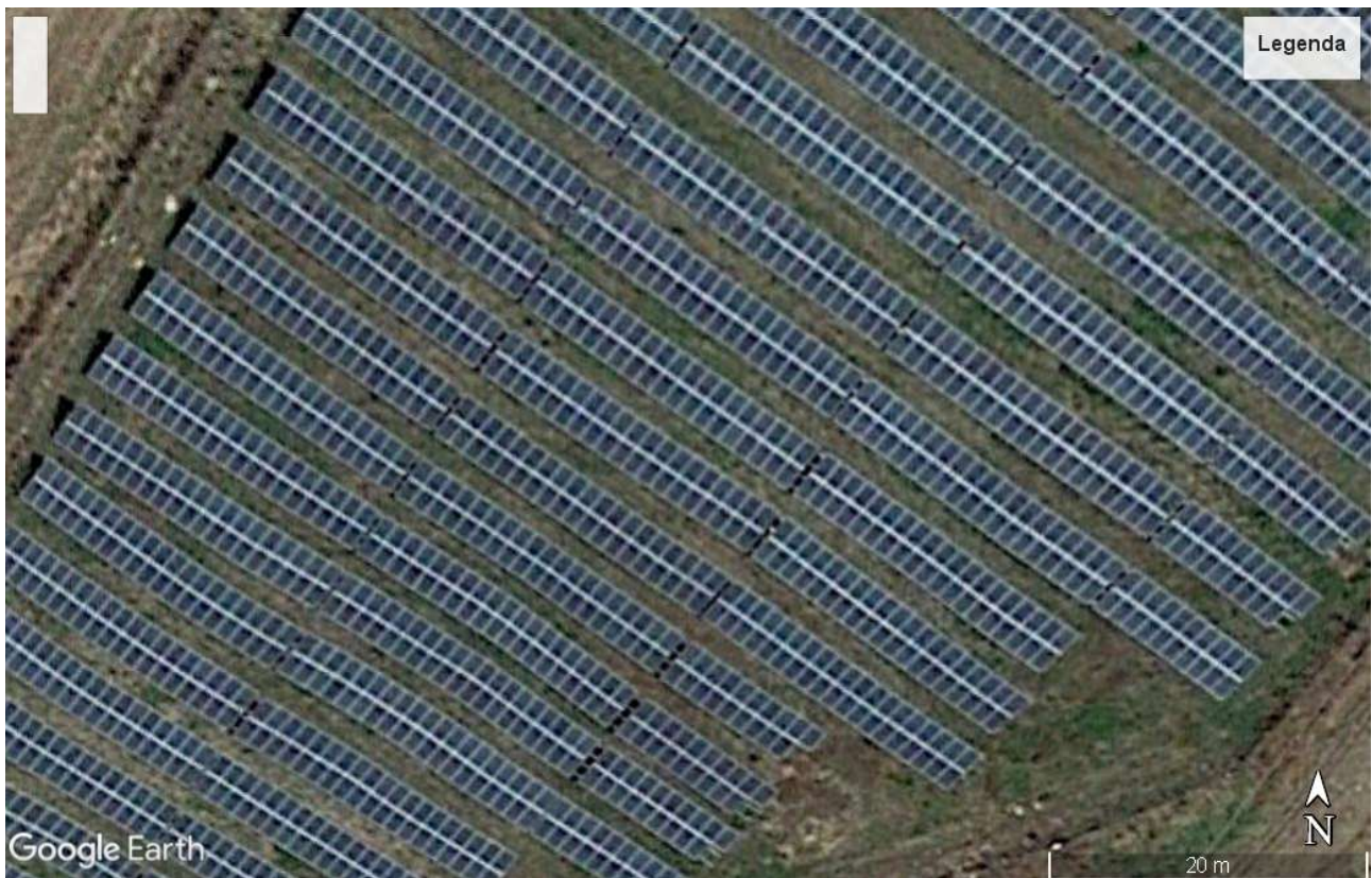
Esempio 3 da 20 metri di altezza - Molise
