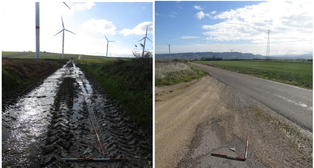
Tratto di raccordo tra la SP 104 e la Strada Comunale Ascoli-Deliceto
