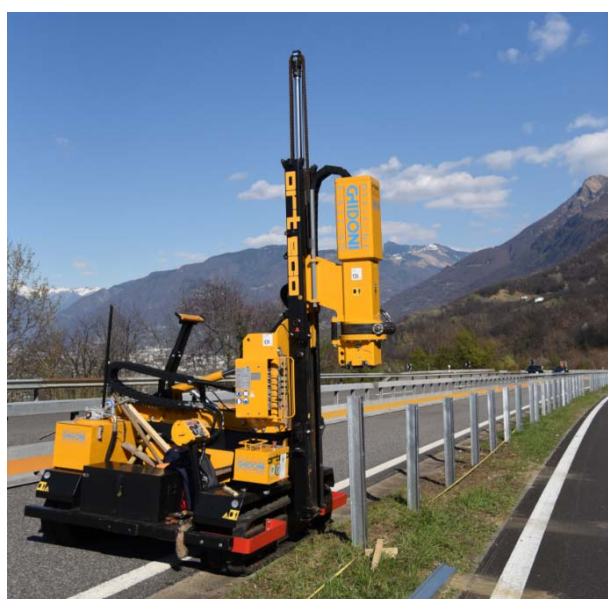
Fig.1 – Esempio di battipalo
