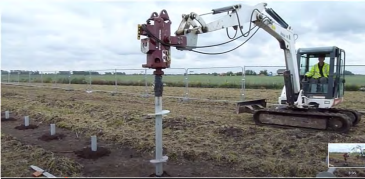
Figura 2-5 Macchina Operatrice per fissaggio supporti strutture
