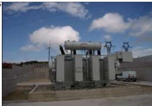
Figura 8-2 Trasformatore MT/AT
