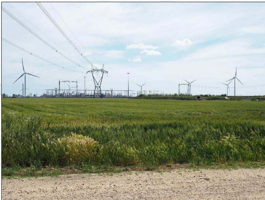
Foto 1.2 – Punto di ripresa est stazione TERNA
