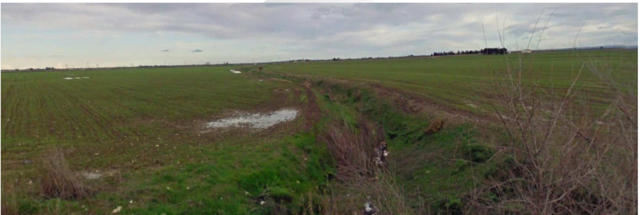
Figura 2-3: Canale Piluso – stato di fatto in corrispondenza dell'intersezione
