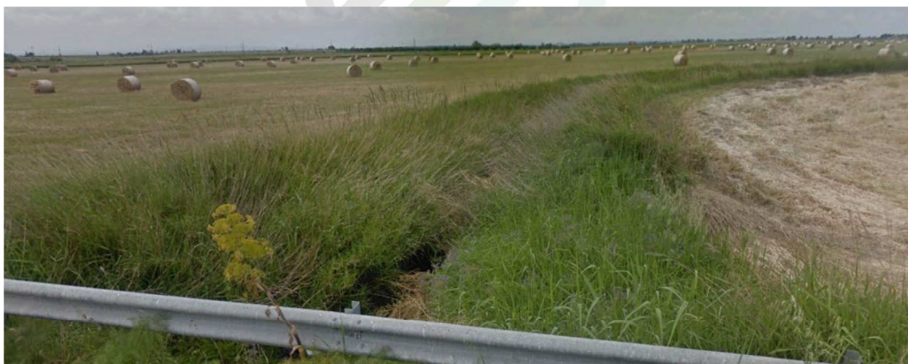
Figura 2-5: Fosso Carapelluzzo – stato di fatto in corrispondenza dell'intersezione
