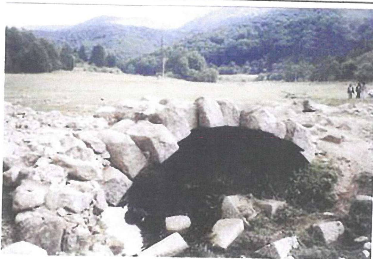
Fig. 11. Porzione del Ponte Romano sul Tassito
