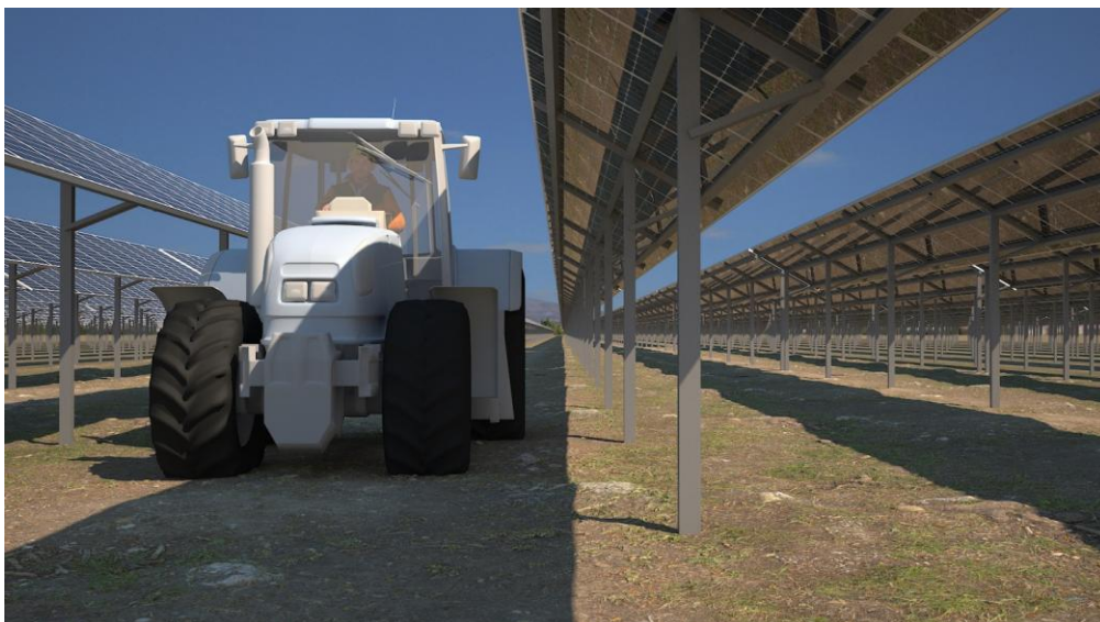
Figura 100: Fotosimulazione - dettaglio impianto tipo AGV.
