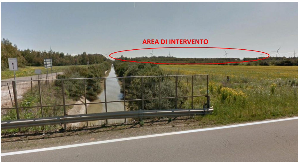
Figura 74: Vista situazione attuale da PB B sul ponte della SP 61.
