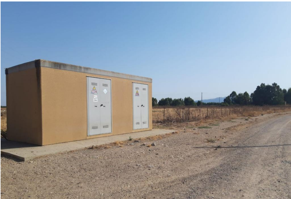
Figura 34: Cabine di trasformazione su stradello.
