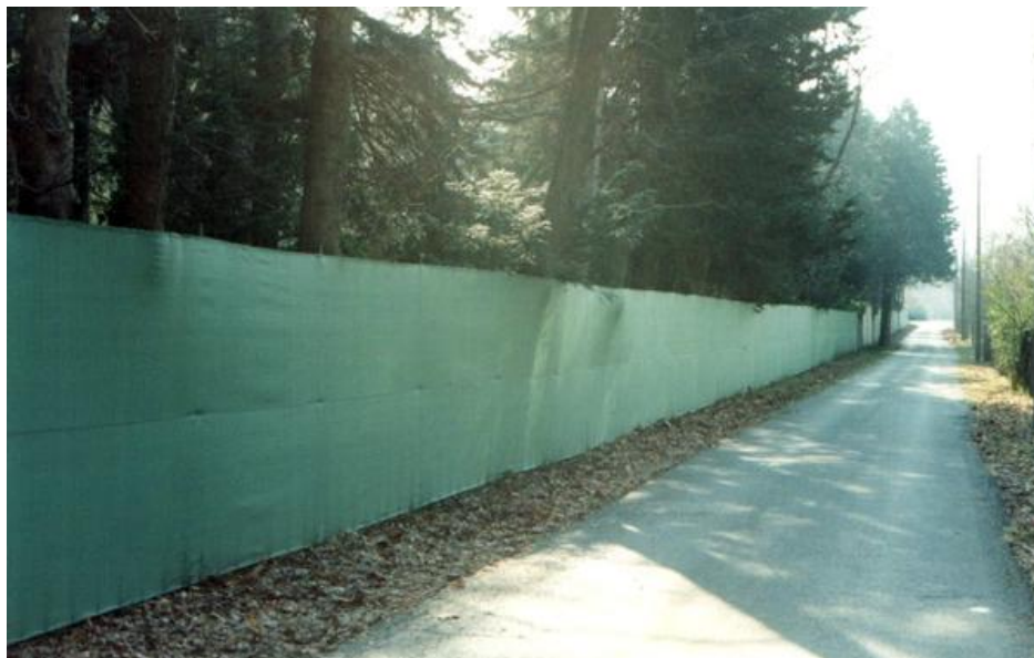
Figura 79: Esempio applicazione di reti antipolvere e frangivista.
