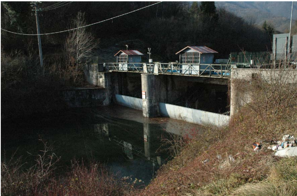
Figura 48: foto traversa esistente lato lago
