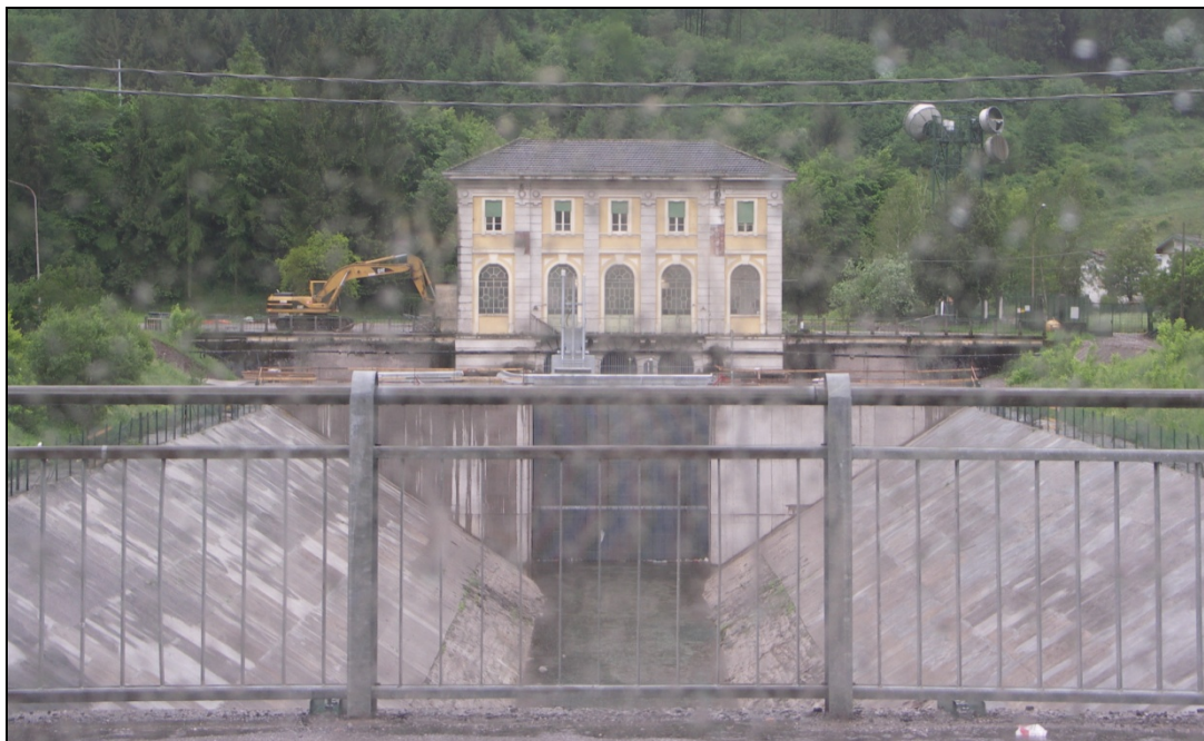
Figura 11 : il canale di presa dal lago nell'abitato di Idro con sullo sfondo il manufatto di ingresso alla galleria Enel.
