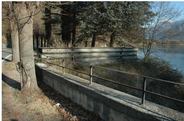
Figura 54: foto panconi metallici esistenti
