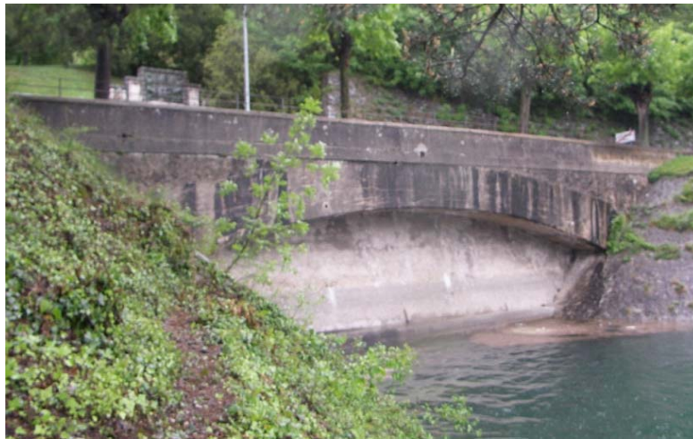
Figura 53: foto galleria esistente – zona imbocco
