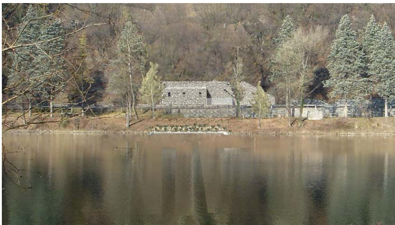
Figura 26: inserimento dell'opera di imbocco della nuova galleria di by-pass con lo stato di fatto (sopra)
