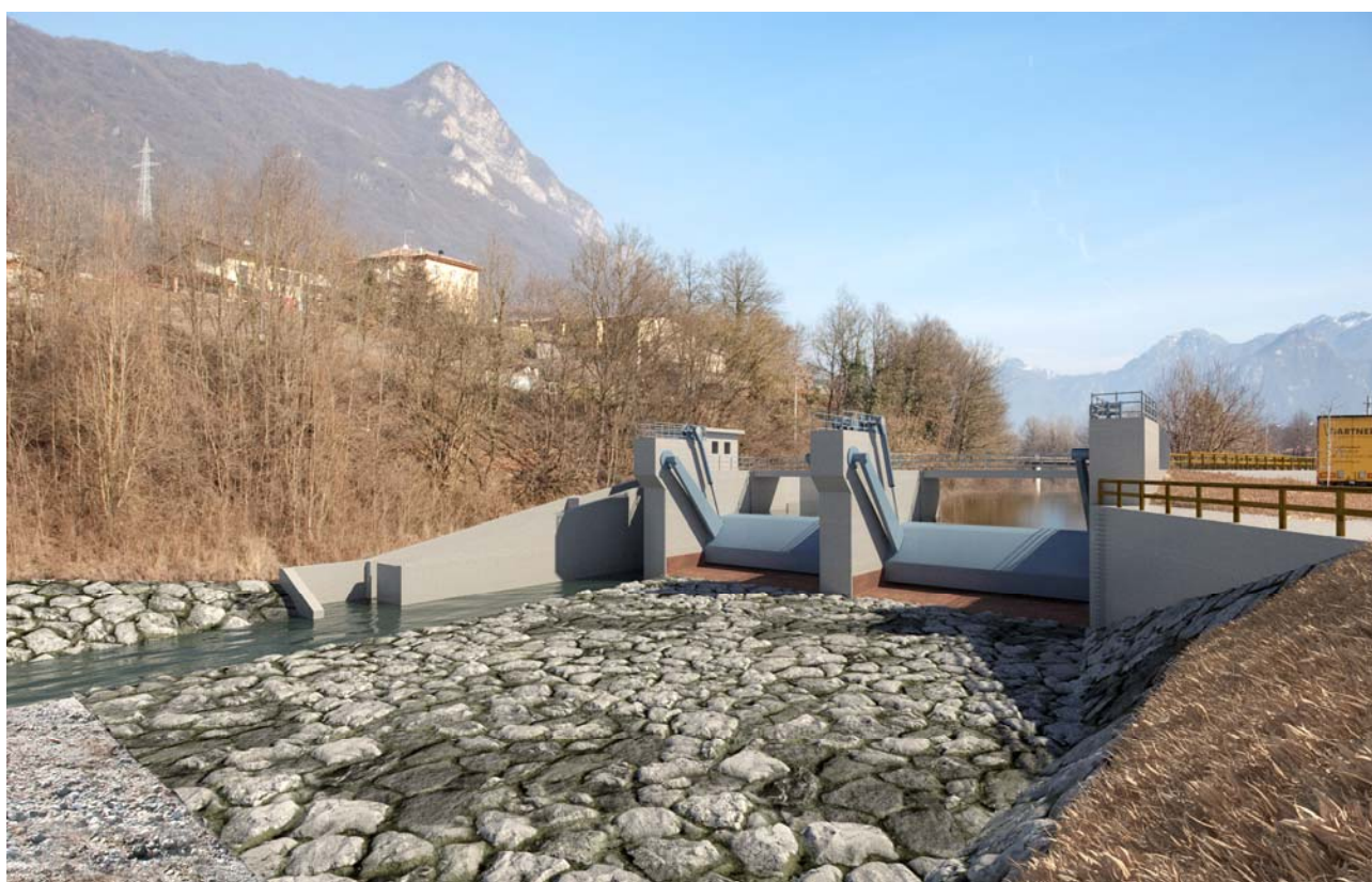
Figura 47: vista da valle della nuova traversa con passaggio del minimo deflusso vitale e raffronto con lo stato di fatto (sopra)
