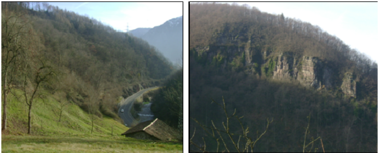
Figura 3 – Particolare di terrazzi stabili e orli di scarpata rocciosa nel tratto di versante interessato dalla realizzazione della galleria in progetto.
