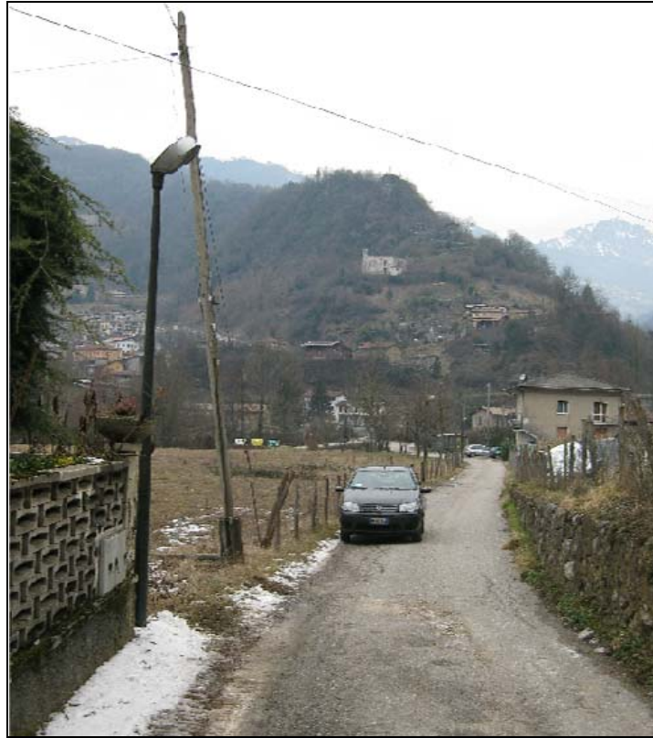
Figura 10 – Area dello sbocco, via Marconi
