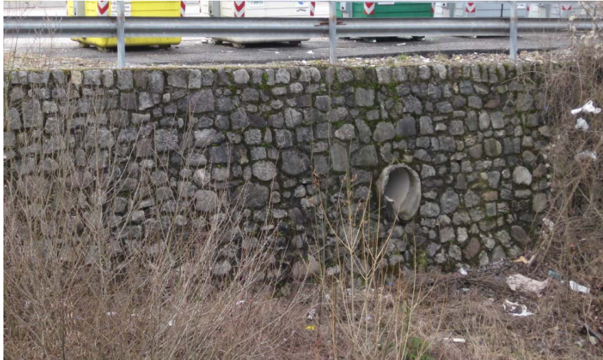
Figura 22 – Scarichi acque bianche nel fiume Chiese presenti in via dei Baicc nel tratto compreso tra il ponte esistente e la traversa di progetto.
