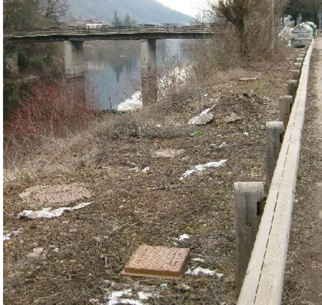
Figura 20 – Pozzetti presenti lungo il tratto di sponda sinistra oggetto dell'intervento.
