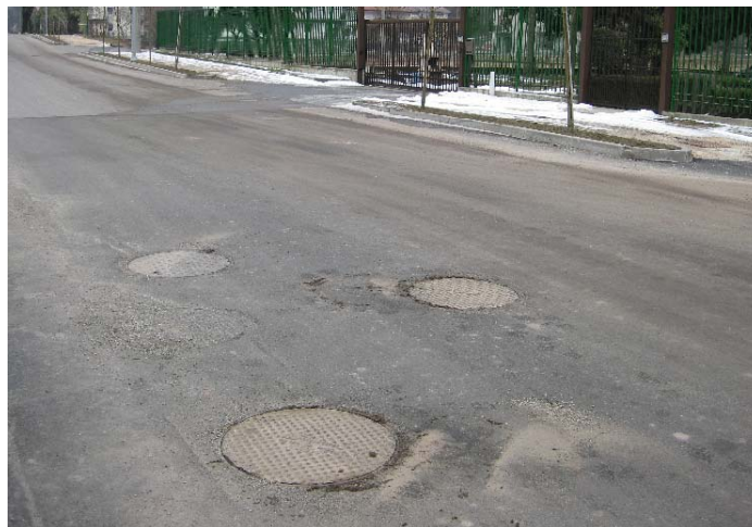
Figura 21 – Pozzetti rete acque bianche presenti in via dei Baicc in corrispondenza della traversa di progetto.
