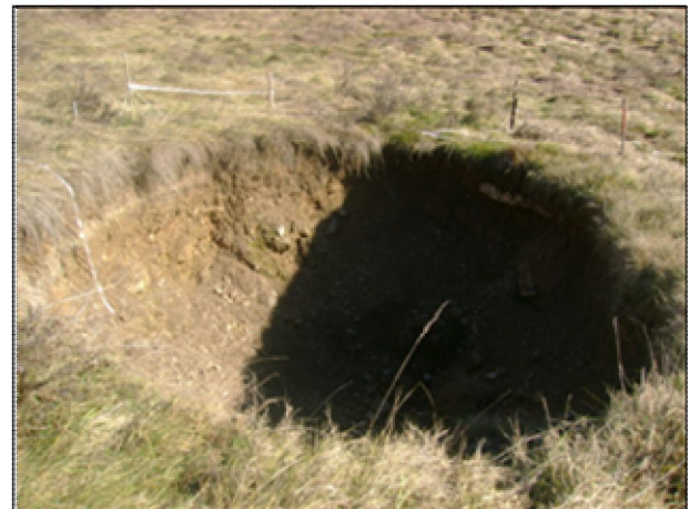
Figura 22: particolare di corpo di paleofrana di crollo e di conoide di deiezione/detritica e un esempio di evidenza superficiale di fenomeni di sfornellamento a carico della vecchia Galleria degli Agricoltori.
