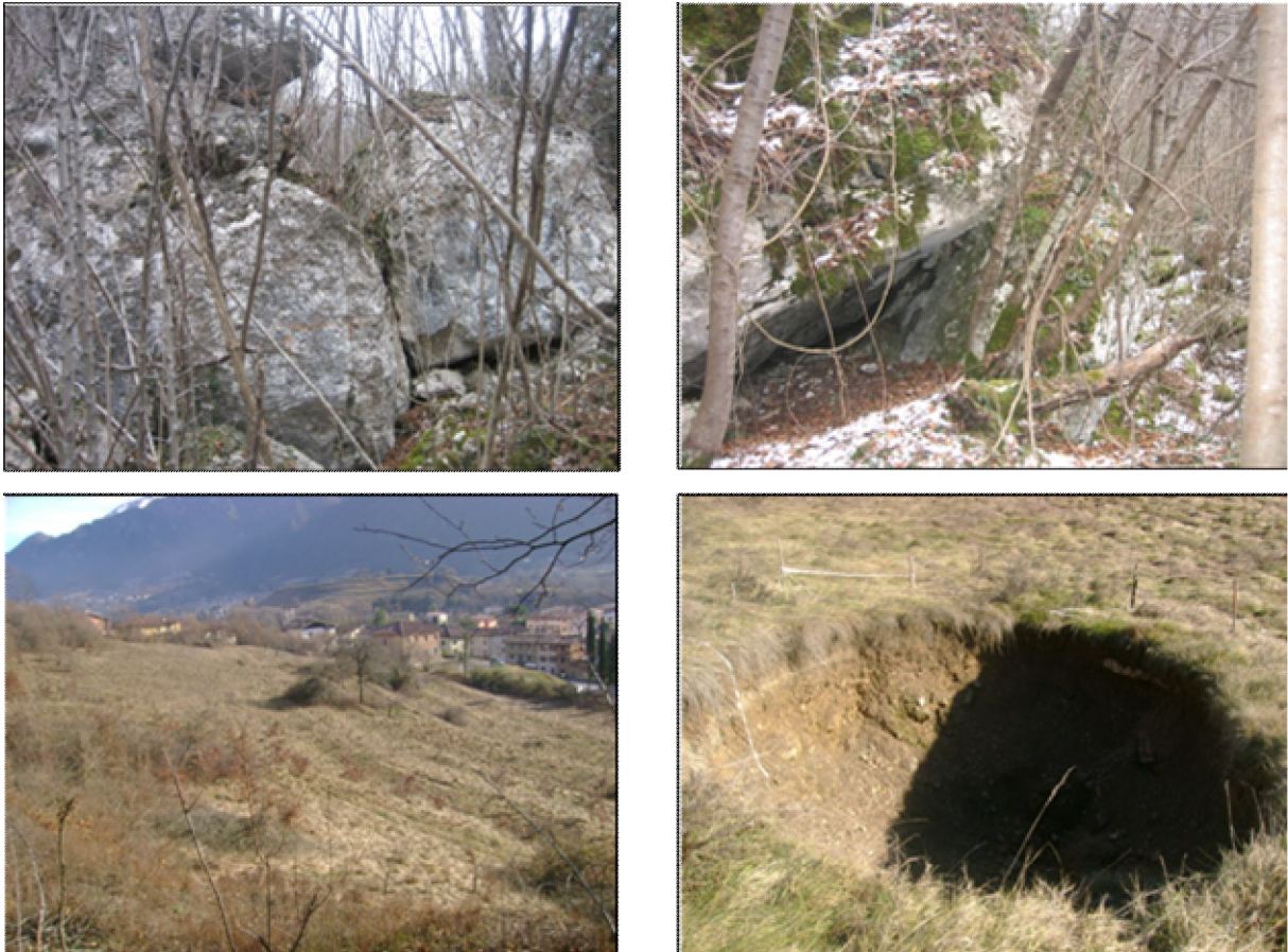
Figura 2.2 – Particolare di corpo di paleofrana di crollo e di conoide di deiezione/detritica e un esempio di evidenza superficiale di fenomeni di sfornellamento a carico della vecchia Galleria degli Agricoltori.
