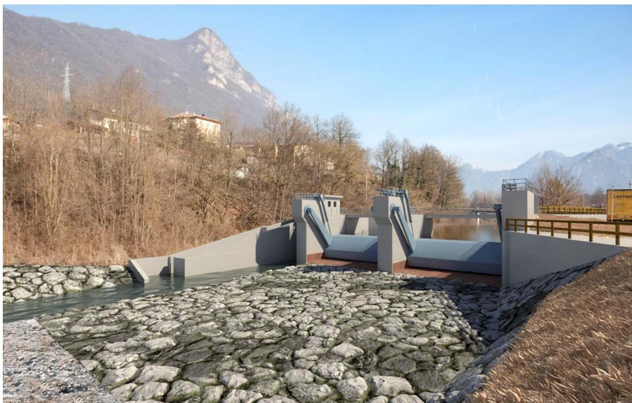
Figura 23: vista da valle della nuova traversa con passaggio del minimo deflusso vitale – Situazioni idrometriche minime nel lago.
