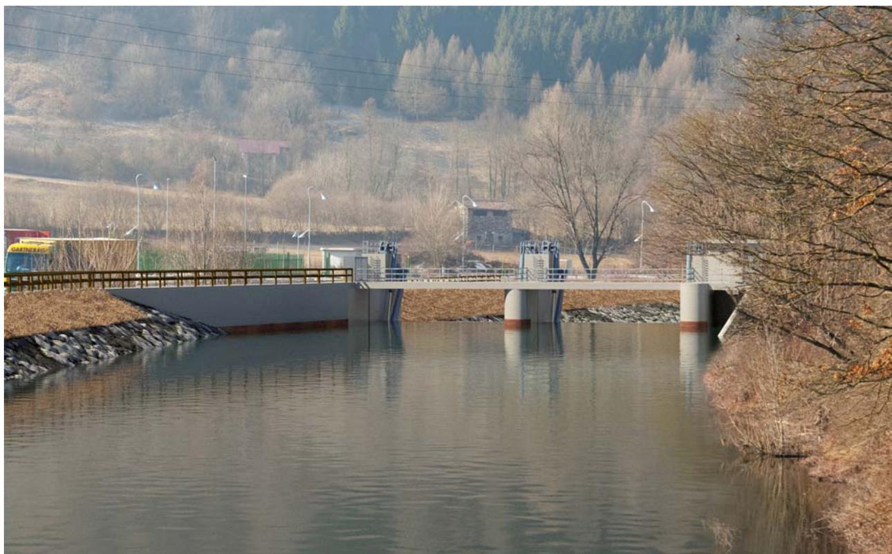
Figura 22: vista da monte della nuova traversa con livello alla massima regolazione di 368.00 m slm
