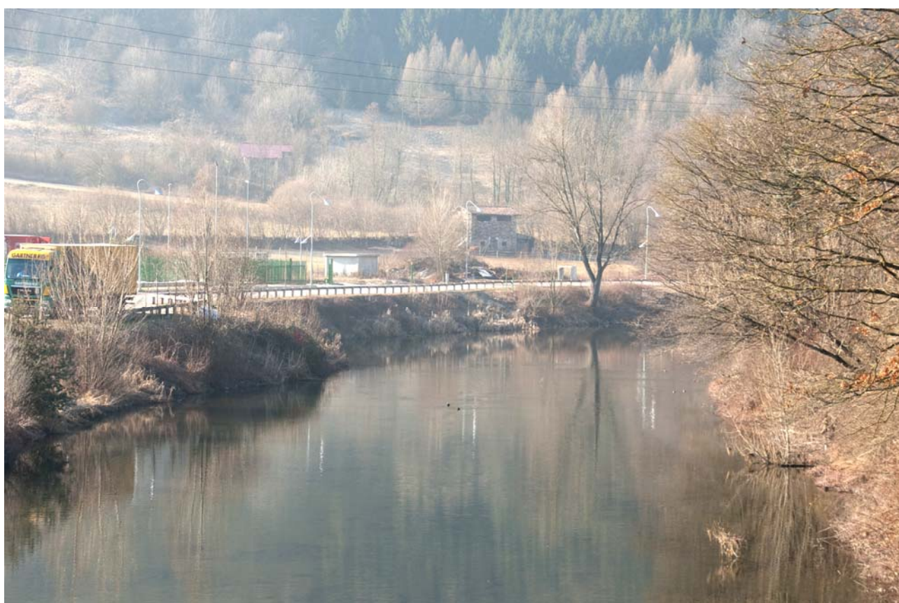
Figura 44: vista da monte del sito di realizzazione della nuova traversa con livelli idrici elevati.
