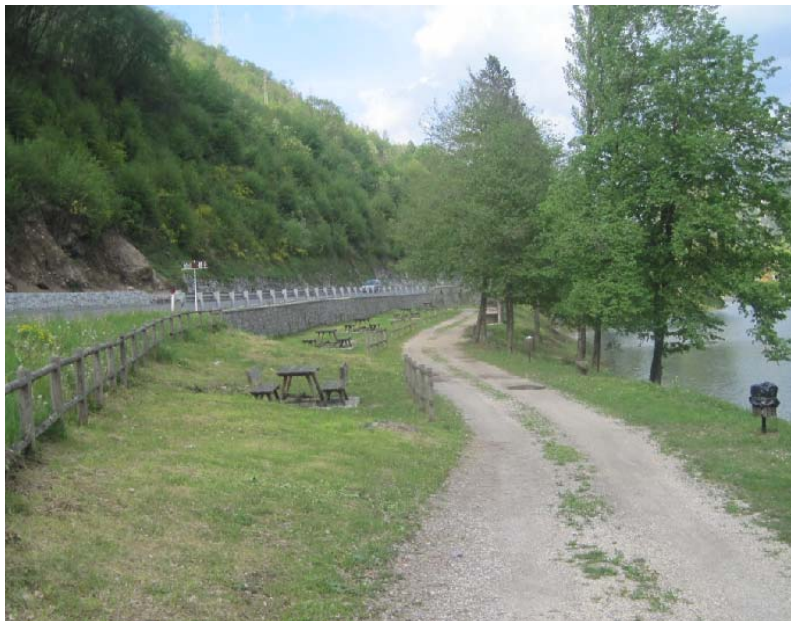
Foto 13: area di future realizzazione dell'opera di imbocco della galleria di by-pass
