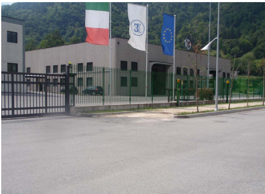
Foto 25: capannoni produttivi nella zona di realizzazione della nuova traversa.
