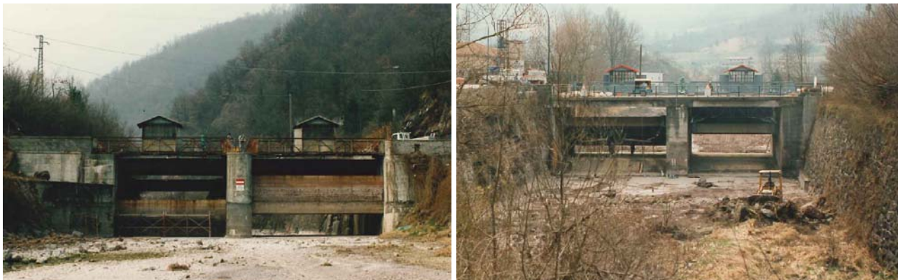
Figura 41: opera di sbarramento vista da monte (sin) e da valle (dx) nei periodi di minima regolazione del lago.
