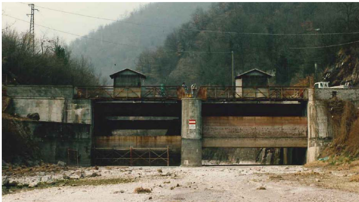
Figura 48: traversa esistente allo stato di fatto con quote minime di regolazione del lago.
