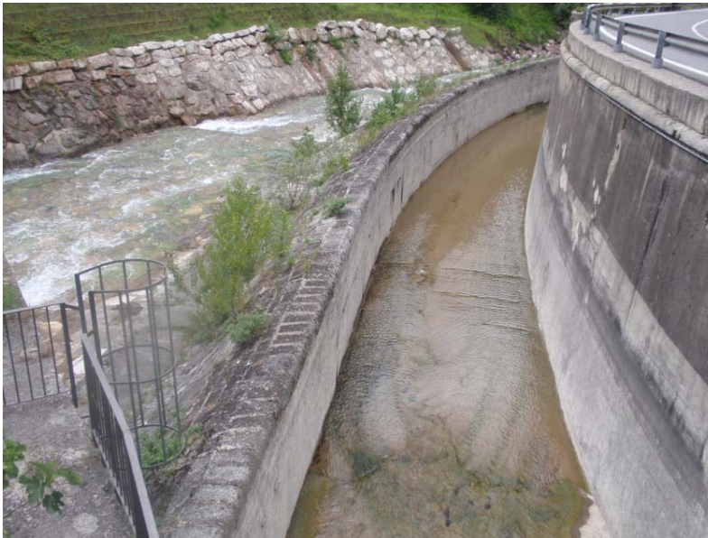
Foto 23: opera di restituzione della galleria degli agricoltori
