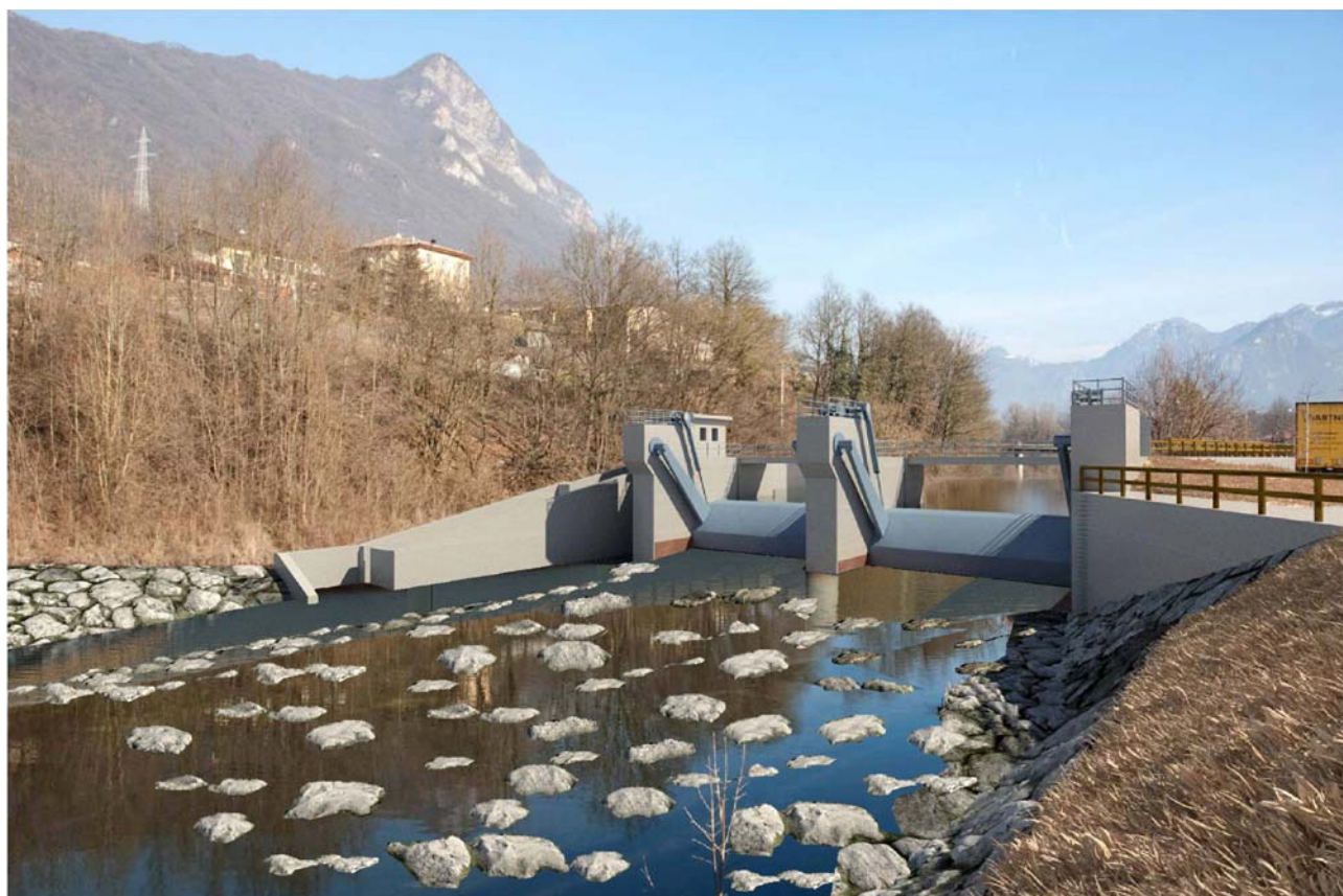
Figura 47: vista da valle del sito di realizzazione della nuova traversa nella situazione di progetto con livelli idrici elevati nel lago e rilascio del DMV.
