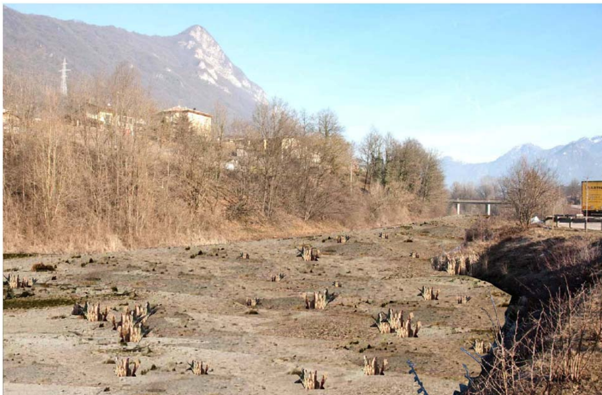
Figura 42: stato di fatto al minimo livello – vista da valle
