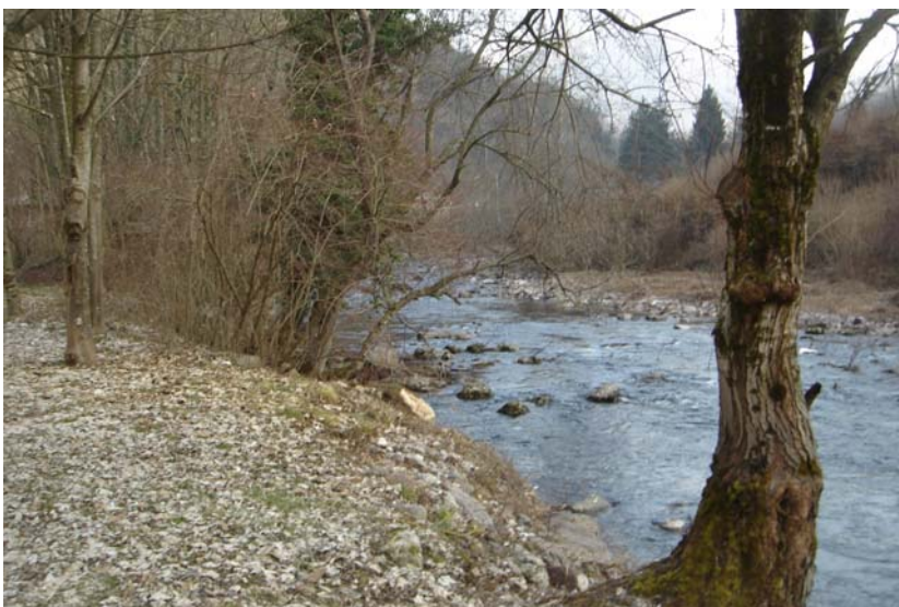
Foto 30: Fascia ripariale del Fiume Chiese interessata dal cantiere allo sbocco della galleria
