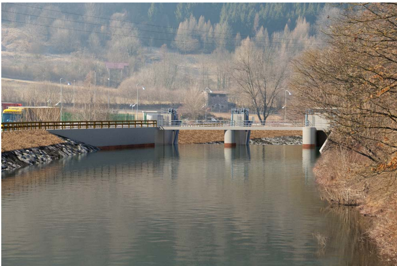
Figura 45: vista da monte della nuova traversa con livello alla massima regolazione di 368.00 m slm.
