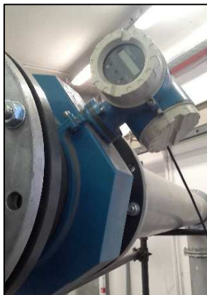
Figura 27. Misuratore magnetico sulla linea DN300 di alimentazione della galleria e caratteristiche tecniche
