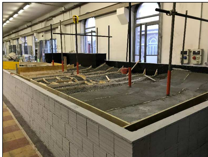
Figura 21. Realizzazione del tratto di confluenza con sagomatura dell'alveo del Fiume Chiese e finitura superficiale in sabbia e cemento
