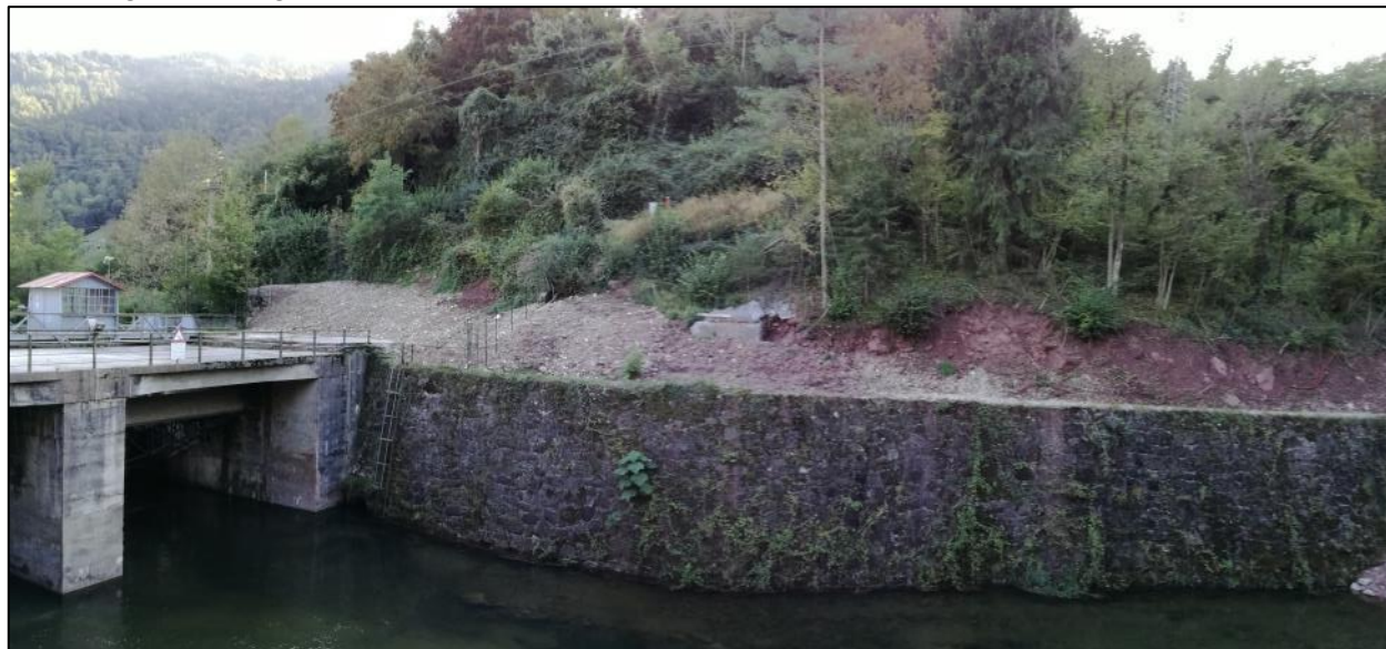
Figura 12 - Piede della paleofrana a lenta deformazione, in prossimità della traversa esistente, dove è presente un orlo di scarpata erosionale
