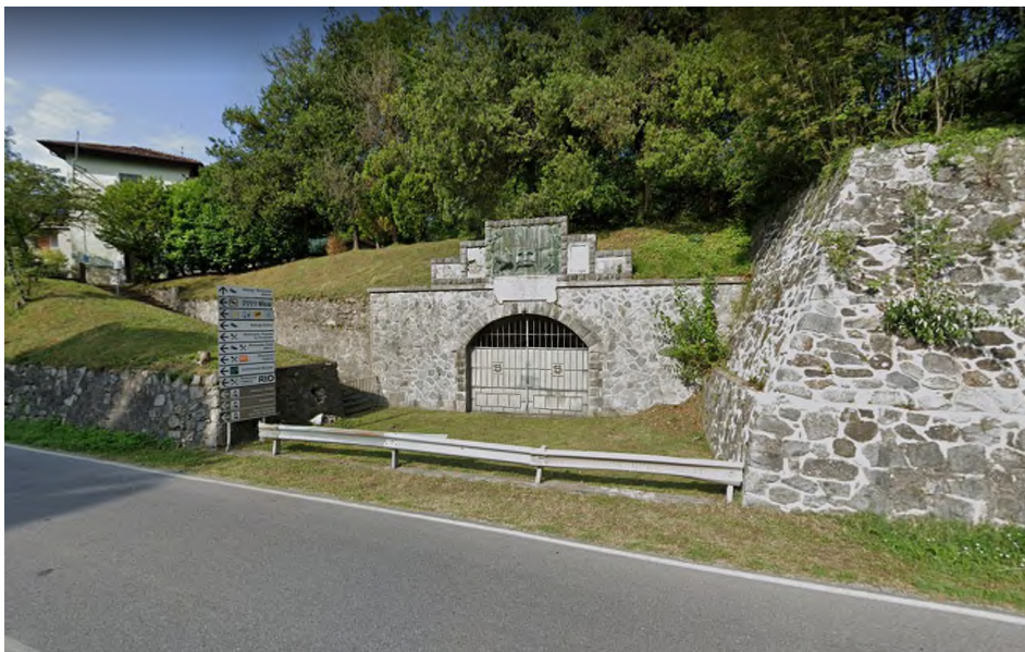
Foto n° 4.2 Vista imbocco lato monte della galleria degli agricoltori
