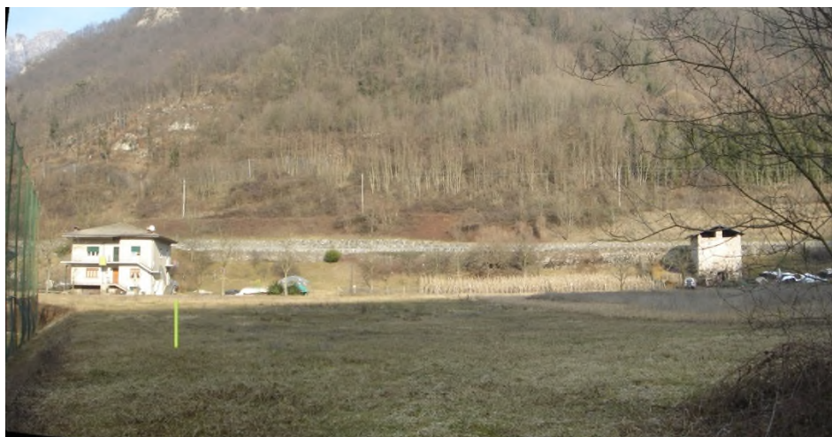
Foto n° 2.3 Vista zona sbocco (galleria artificiale verso galleria naturale)
