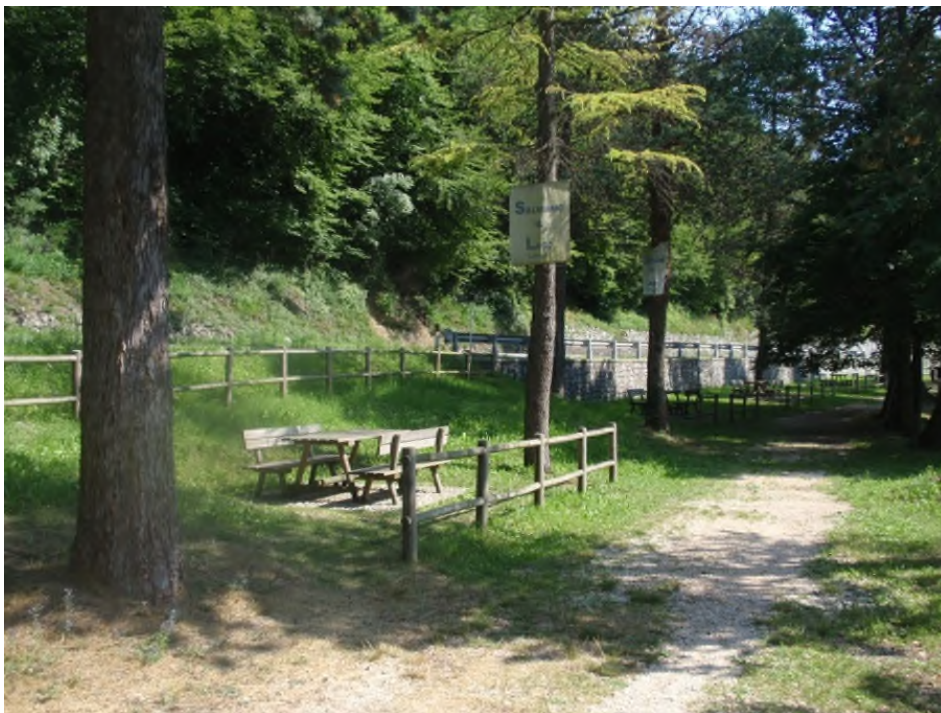
Foto n° 1.2 Vista zona imbocco
