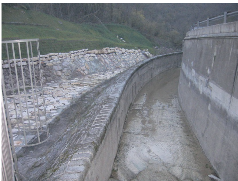
Foto n° 4.4 Vista opera di restituzione allo sbocco della galleria degli agricoltori
