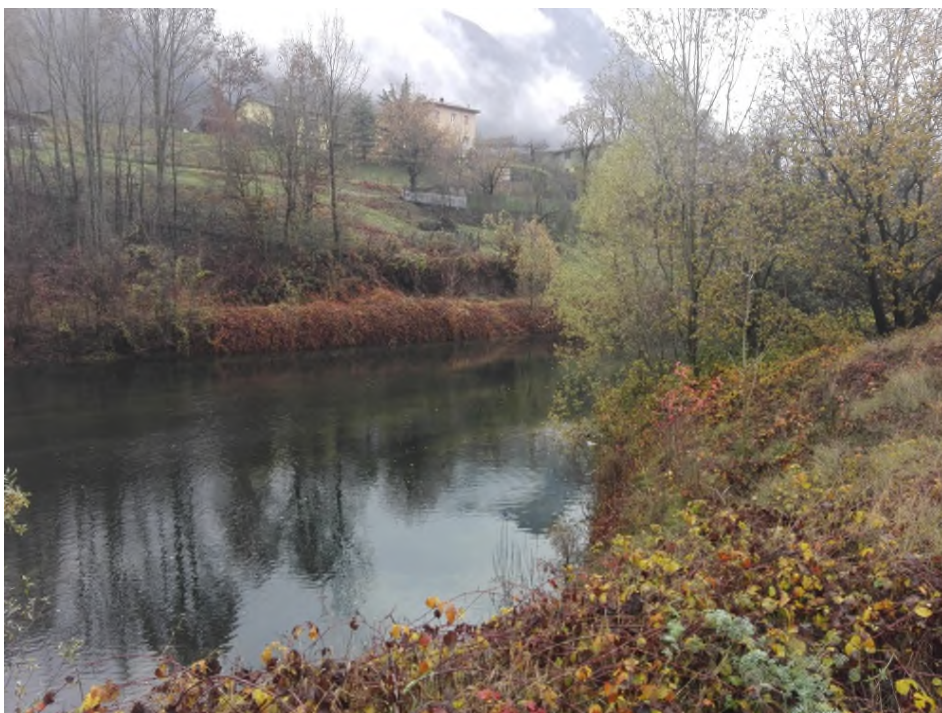
Foto n° 3.6 Vista zona nuova traversa
