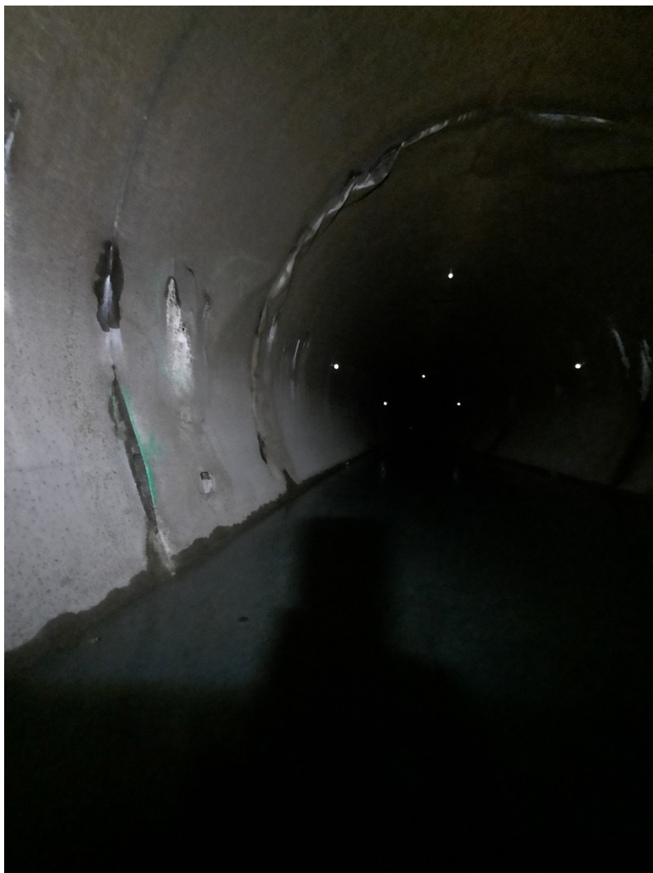
Foto n° 4.5 Vista interna nel tratto foderato della galleria degli agricoltori
