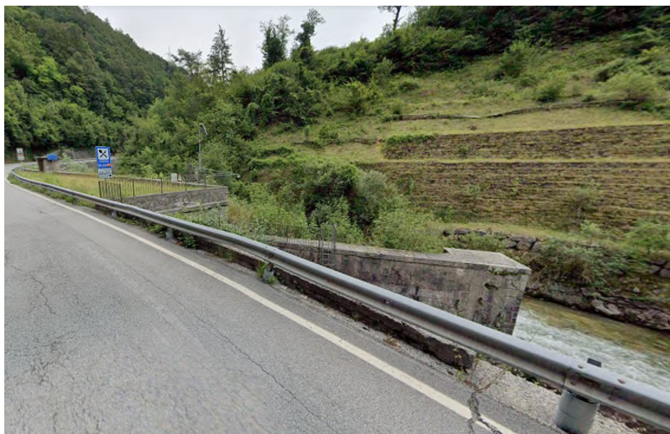
Foto n° 4.3 Vista sbocco della galleria degli agricoltori
