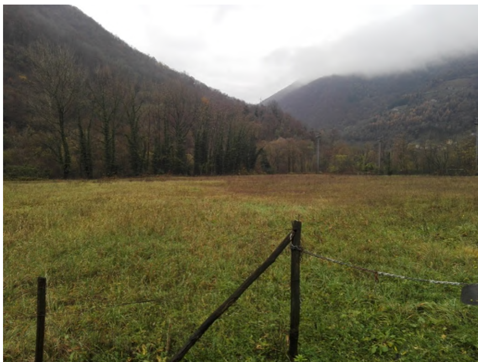
Foto n° 2.8 Vista zona sbocco (tratto galleria artificiale)
