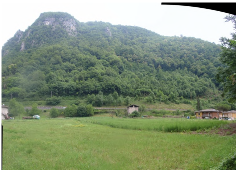
Foto n° 2.2 Vista zona sbocco (galleria artificiale verso galleria naturale)
