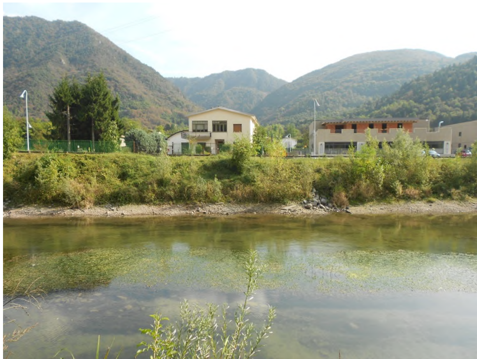
Foto n° 3.4 Vista sponda sinistra tra il ponte e la nuova traversa
