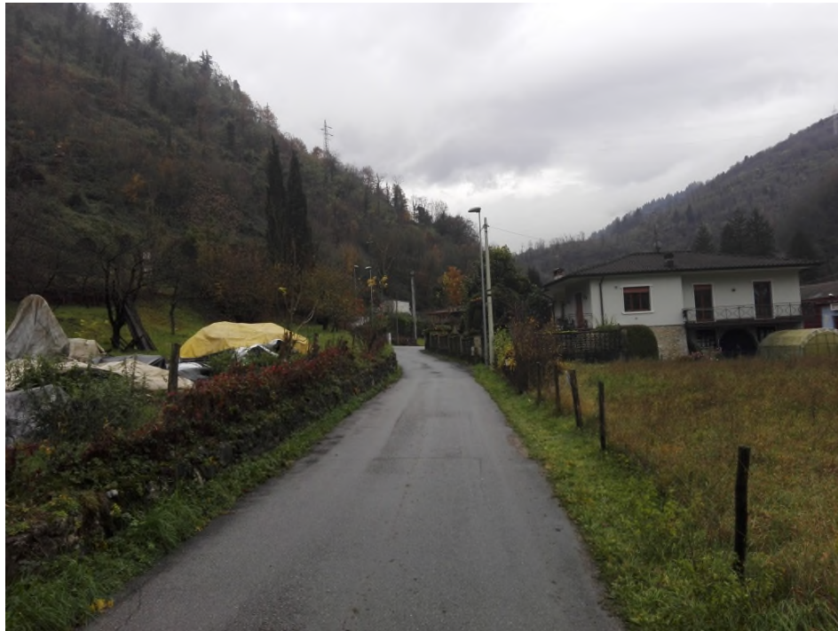
Foto n° 2.9 Vista zona sbocco (galleria artificiale)
