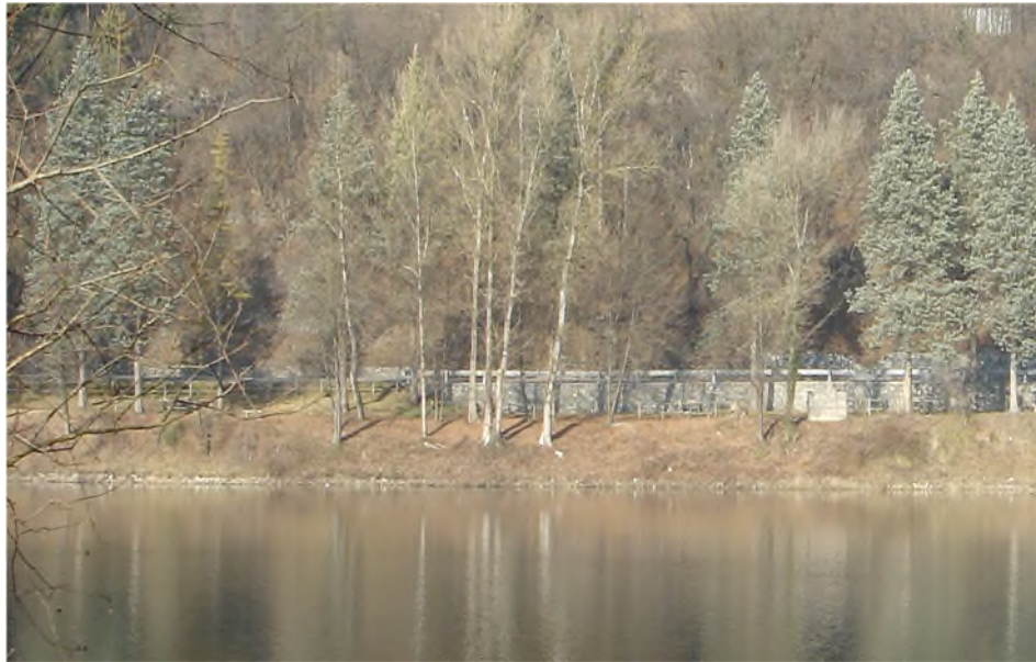
Foto n° 1.3 Vista zona imbocco dal lago
