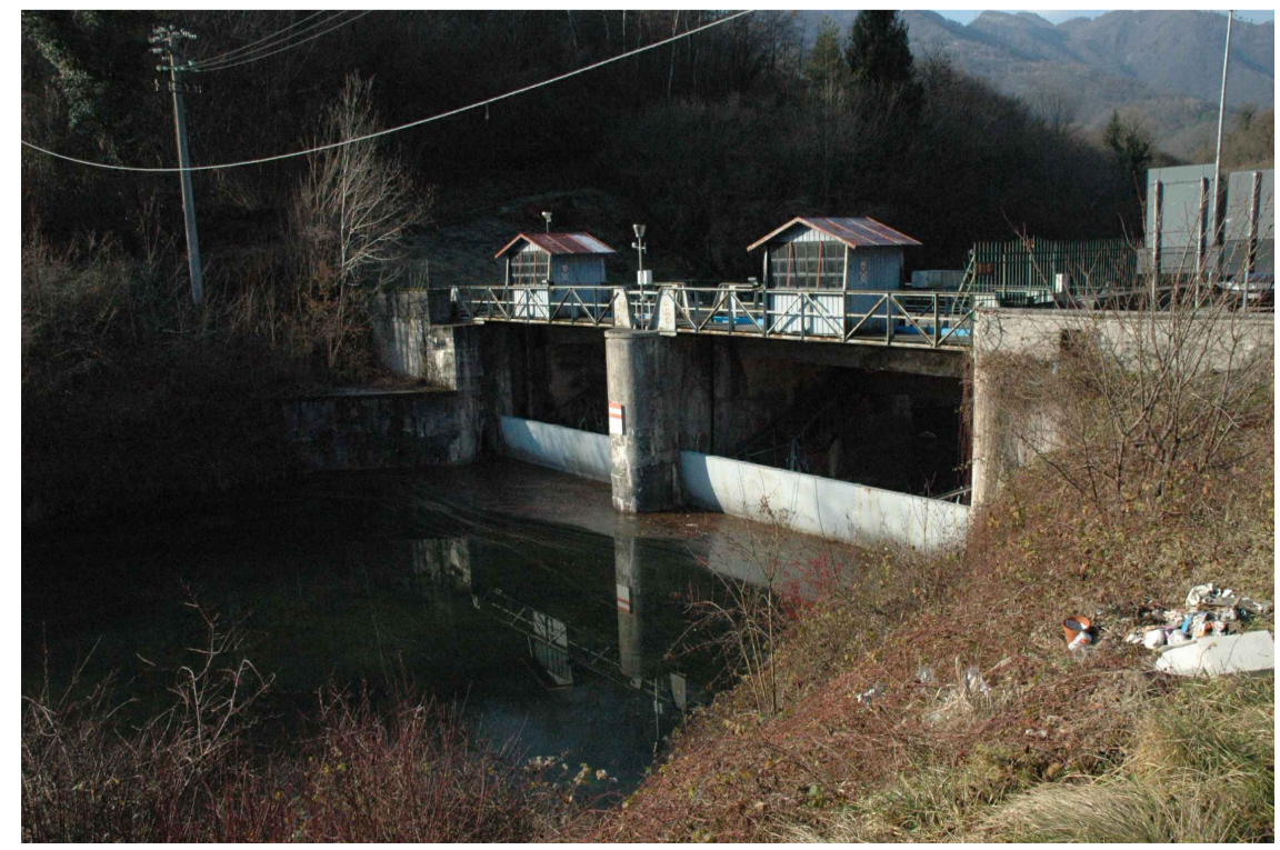
FOTO N.2 : TRAVESSA ESISTENTE LATO LAGO
