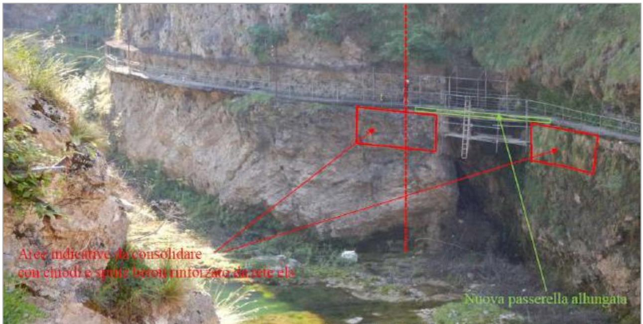
Figura 11: Estratto fotografico dell'area di intervento con schematizzazione dell'area di consolidamento della roccia mediante chiodi e spritz beton
